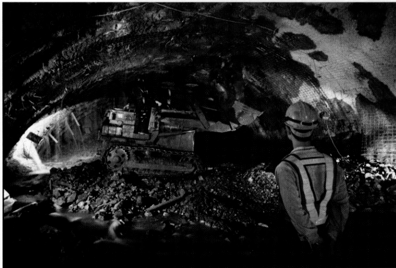
斷層破碎帶改採頂導坑工法施工
