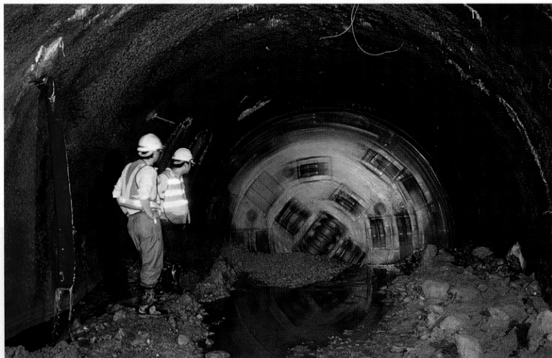
導坑 TBM 開挖（混合工法）
