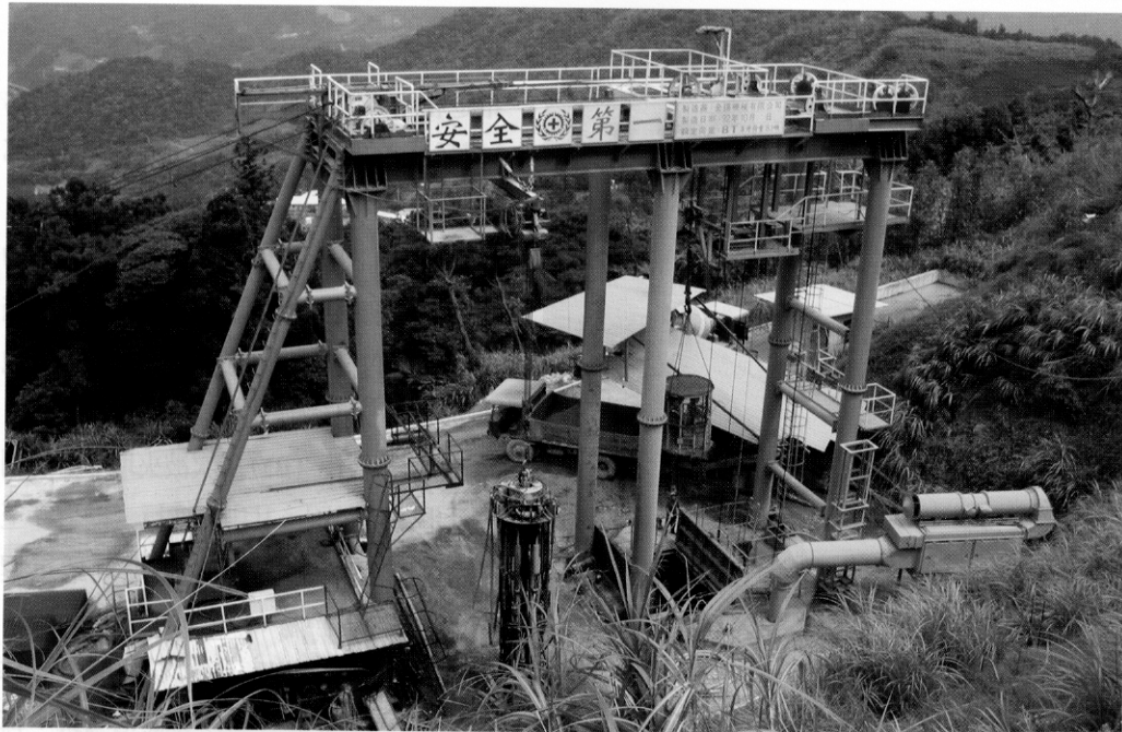
豎井地面門型吊車
