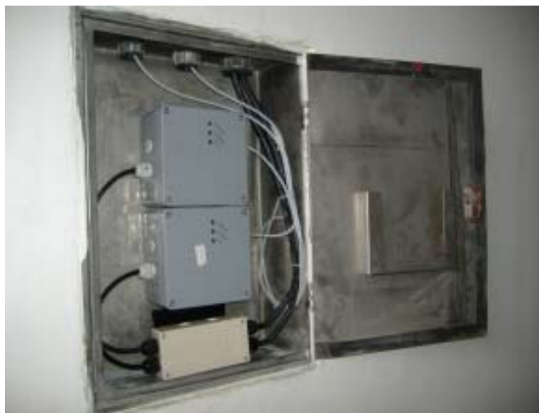
圖 5.1 雪山隧道火警系統現場控制器
