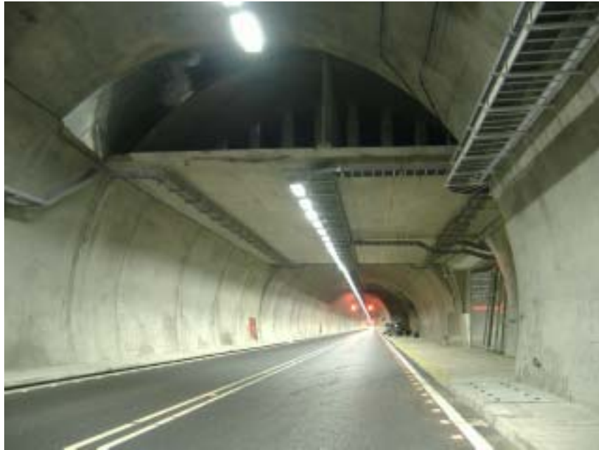
圖 4.3 雪山隧道進氣 RC 風道板
