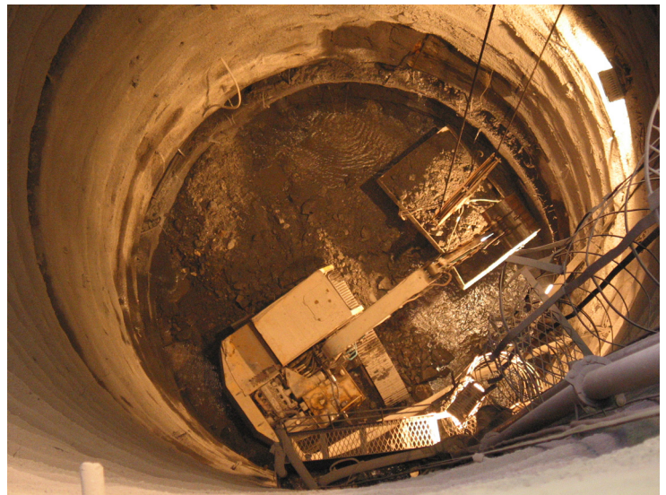
圖 27 降挖工法開挖
