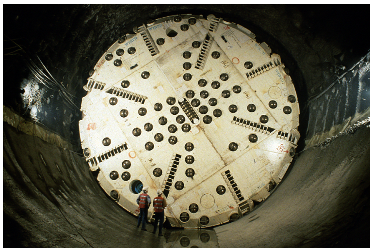
圖 21 雪山隧道主坑 T B M 於鑽炸段內推進實景
