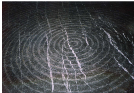
圖 11 導坑東段 36k+204 處 T B M 切削岩面軌跡
