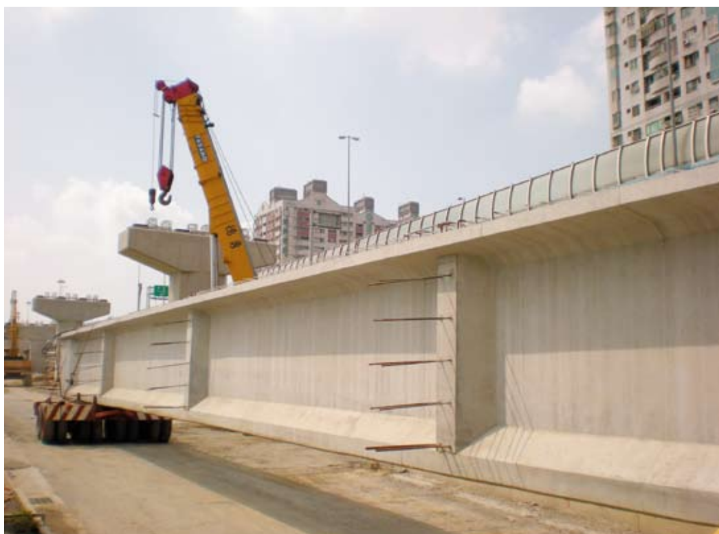
預力梁吊裝作業
