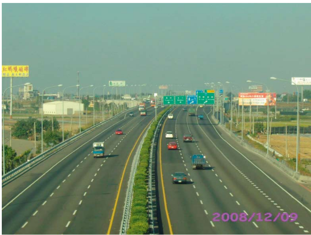
第521標--97.6.15完成3線通車
