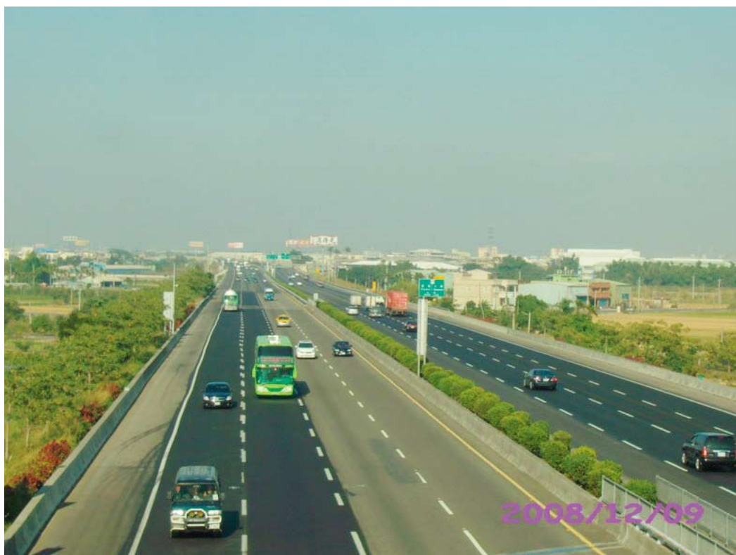
第521標--97.6.15完成4線通車
