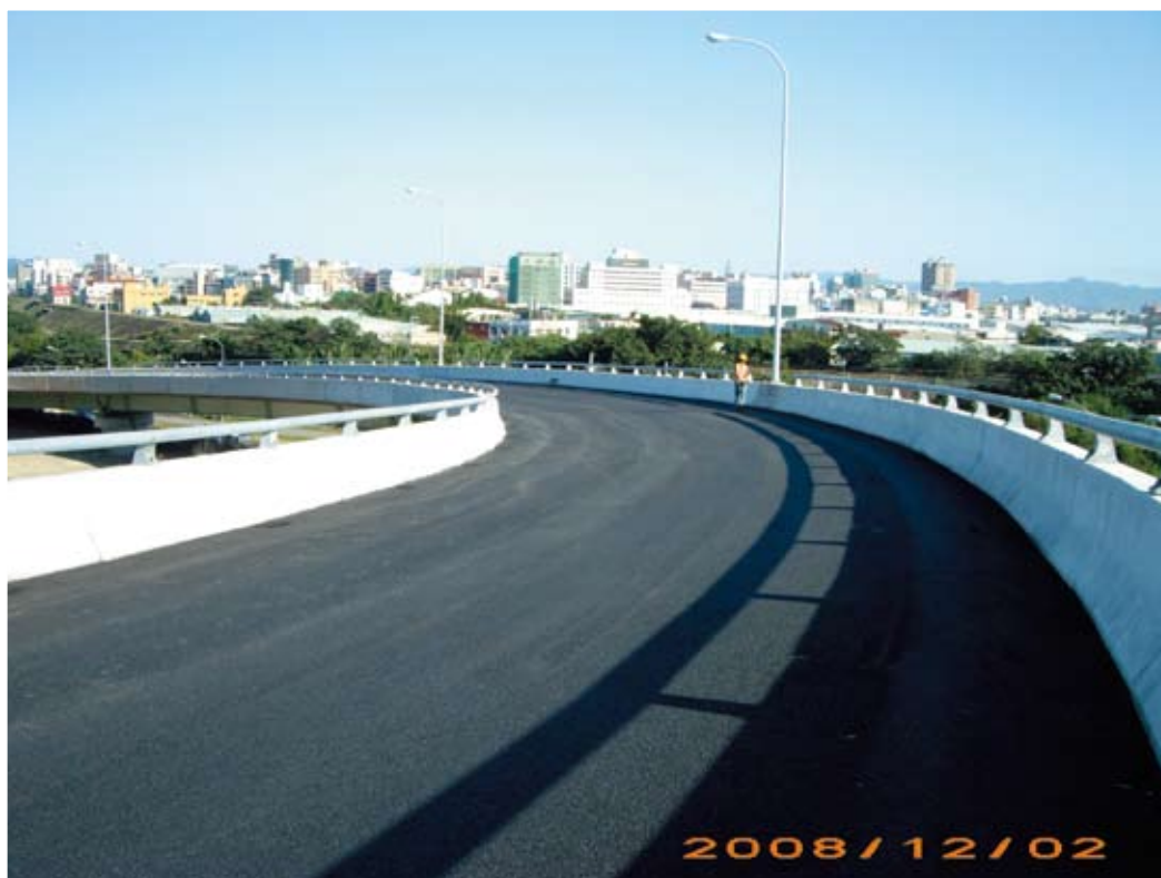
第204標-- A匝道橋面版AC鋪設完成
