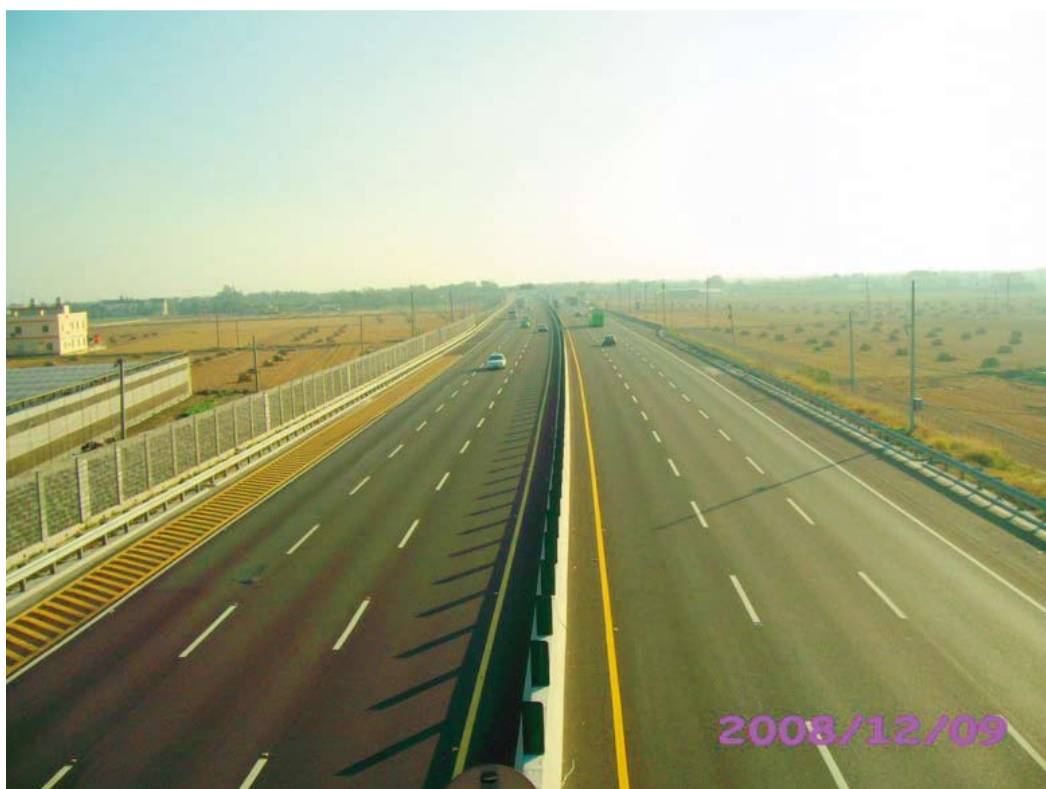
第521標--97.6.15完成3線通車
