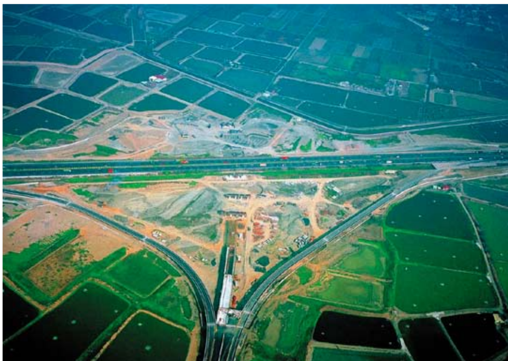
施作匝道A、B及聯絡道之空照圖
