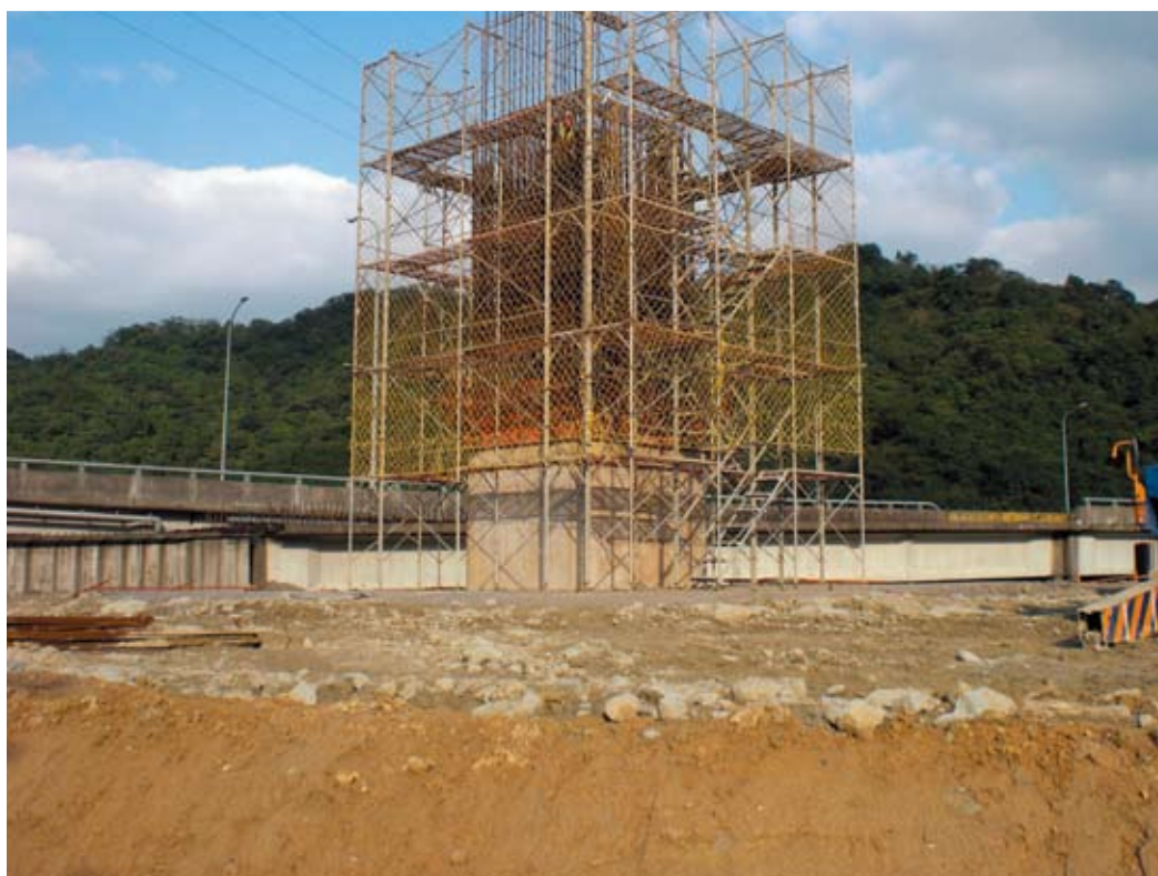
大華系統交流道工程-- EP14樁基礎墩柱搭設施工架鋼筋綁紮作業
