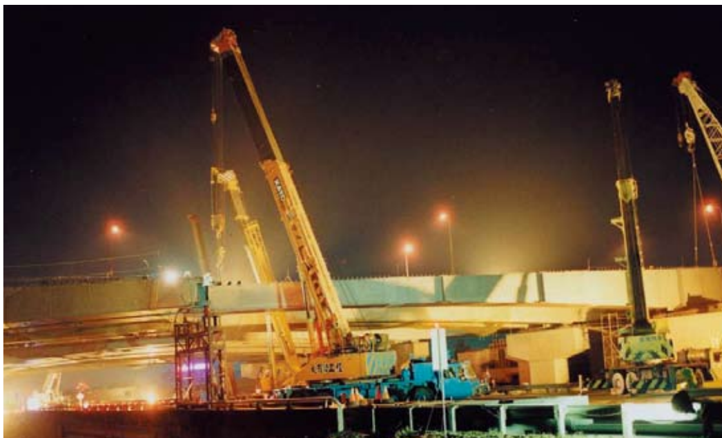
夜間封閉高速公路主線進行吊梁作業
