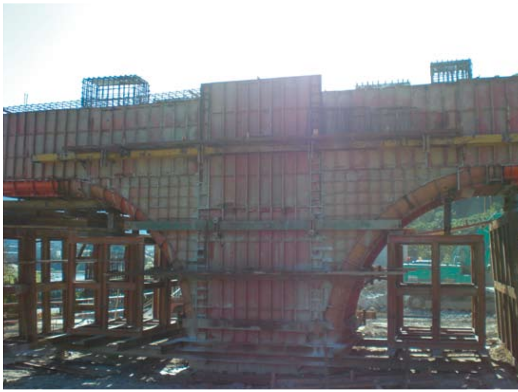
大華系統交流道工程-- H2P6帽樑鋼模組立作業
