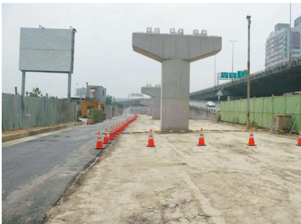
橋墩施作完成
