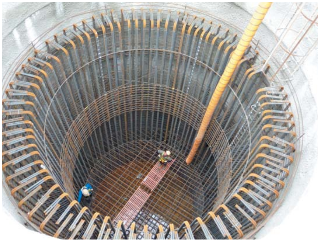
大華系統交流道工程-- EP8井筒式基礎筒身鋼筋綁紮作業
