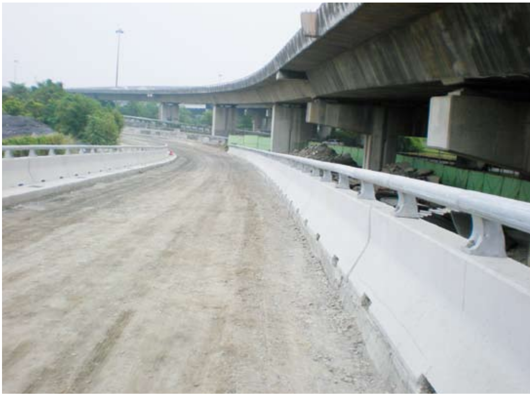
匝道級配底層施作
