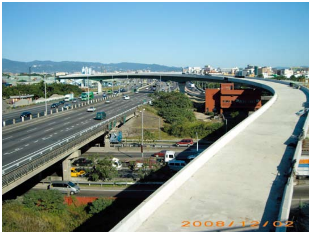
第204標-- C匝道施作現況
