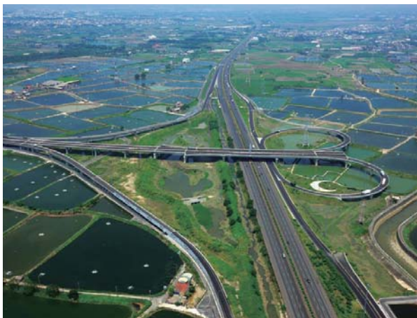
國道1號高雄科學園區交流道 | Kaohsiung Science Park Interchange, National Freeway No.1
