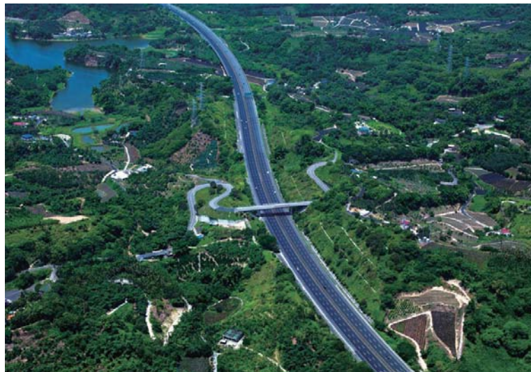
國道3號嘉義民雄路段 | National Freeway No.3, Chiayi's Minxiang Section
