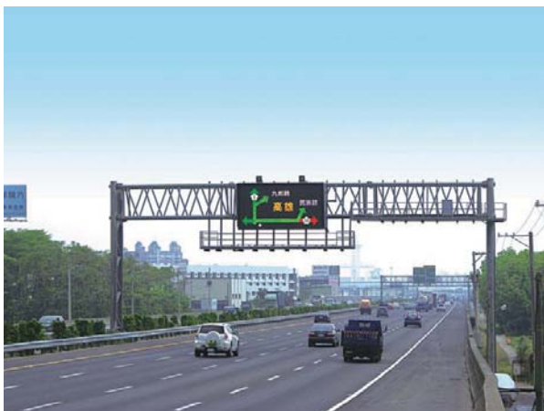
路徑導引標誌 | Route Guidance Sign
