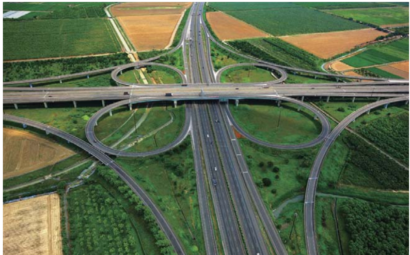
國道1號蔴豆系統交流道 | Chioyi System Interchange, National Freeway No.1
