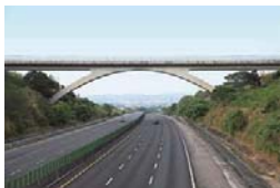
國道3號-橋 | N Bridge, National Freeway No.3
