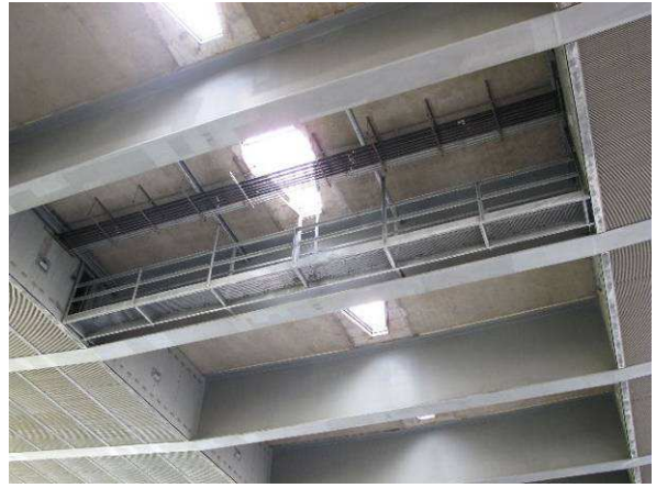
Zakim Bridge 下方鋼構部分維修梯道
