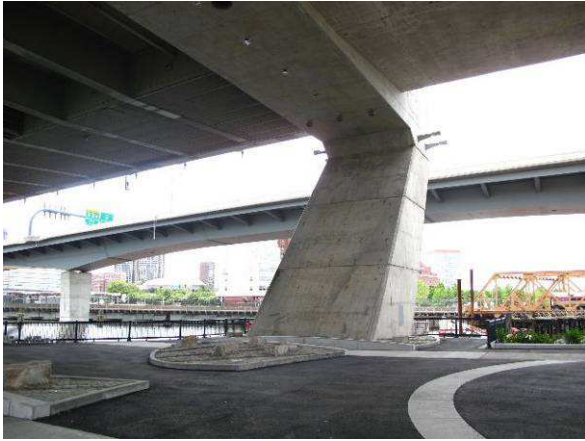
Zakim Bridge 鋼構與混凝土交界部
