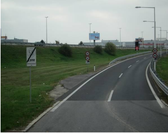
匝道入口各類標誌及標線
