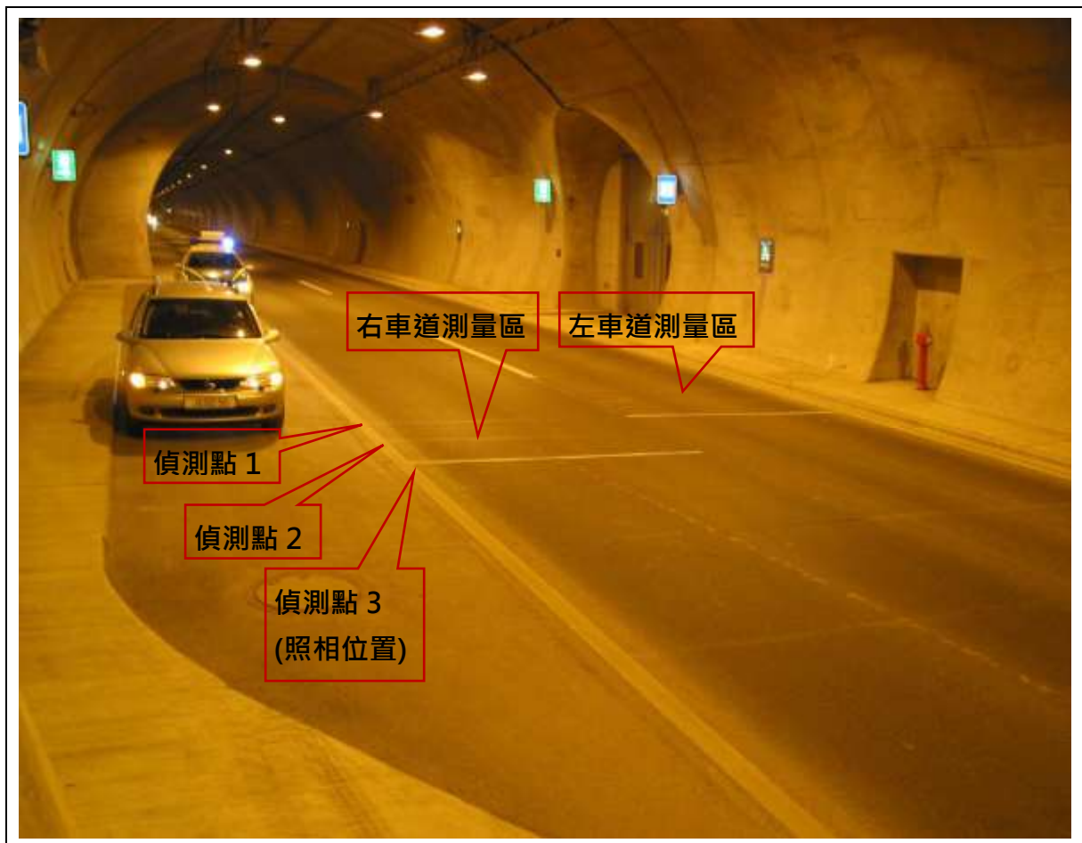
圖3.1.16 車速偵測器佈設方式
