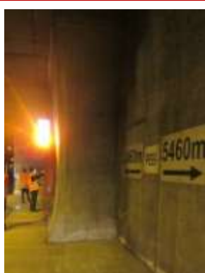
距隧道口里程標示
