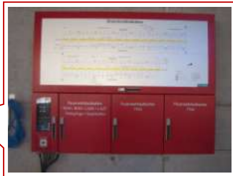
火警系統偵測顯示盤
