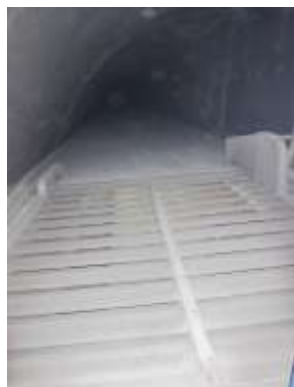
主線平頂排煙孔
