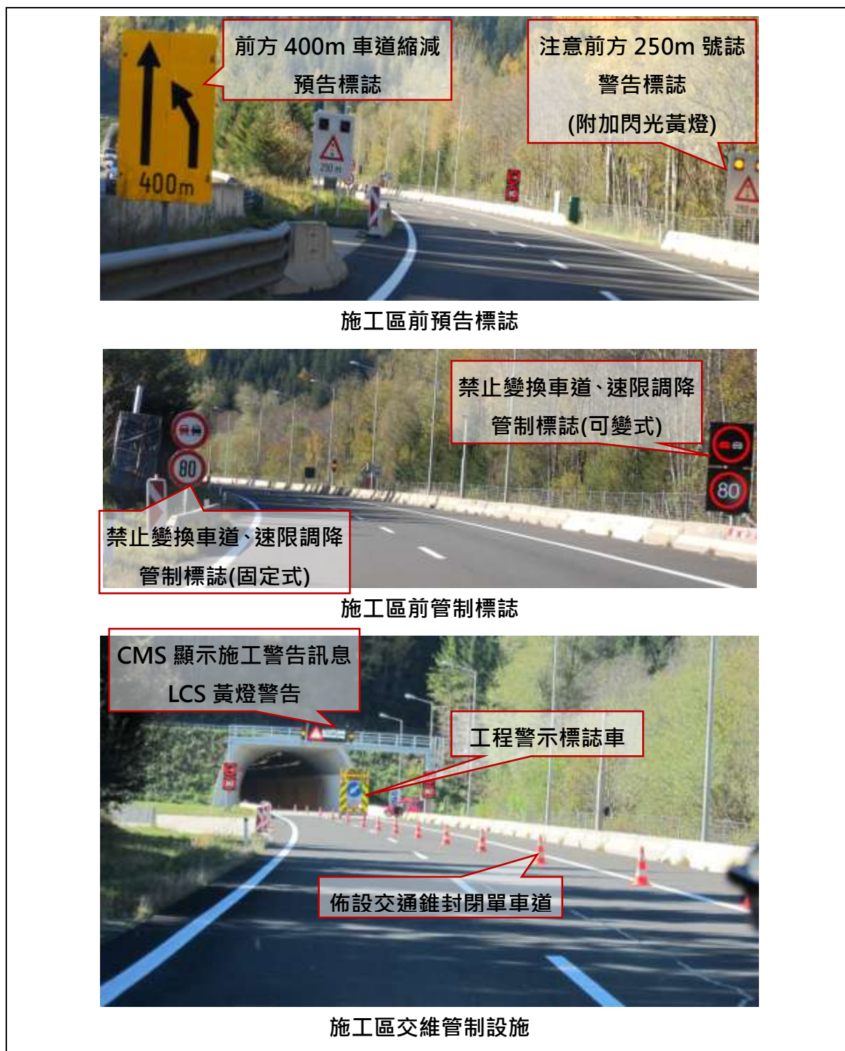
圖3. 2. 23施工標誌考察照片
