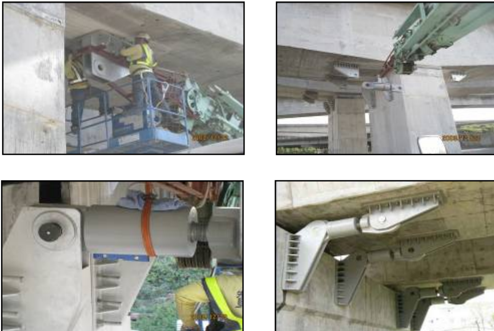
圖 19 地震力量分散裝置安裝施工
