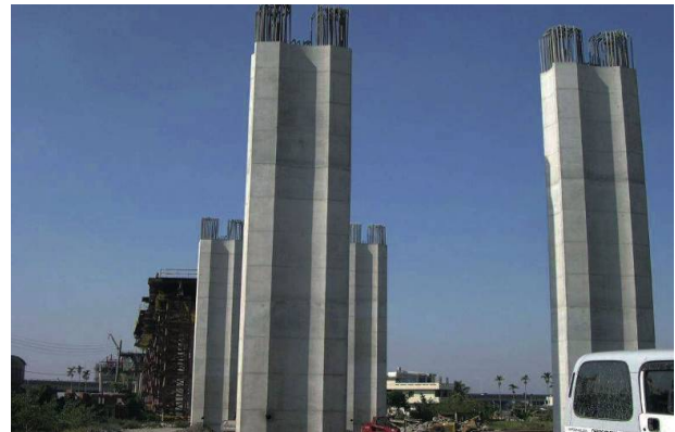
圖 24 自充填混凝土橋墩- 完成面佳
