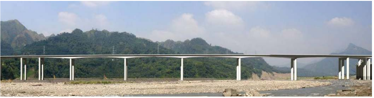
圖 10 國姓高架橋 - 完工後照片
