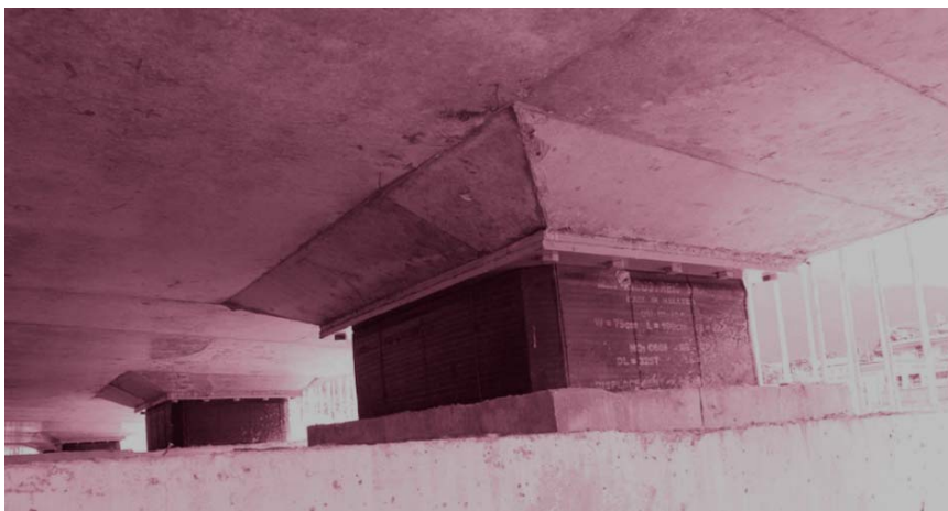
圖 21 鉛心橡膠支承墊照片
