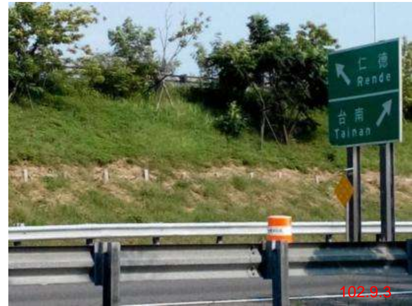
南下327k(下邊坡)完工後
