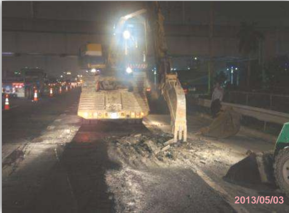
台電至晚上始緊急搶修 採挖土機挖掘回鋪
