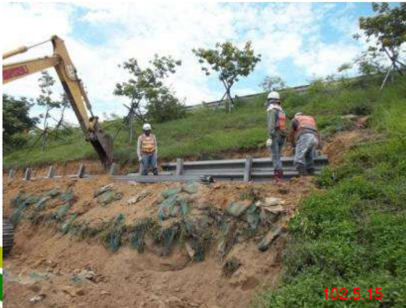
南下327k(下邊坡)施工中
