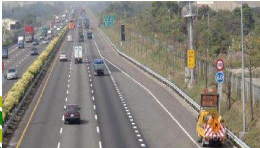
外路肩後方300~500m警戒預告標誌
