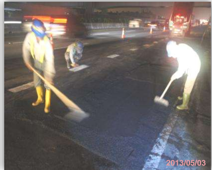
回鋪採人工鋪築
