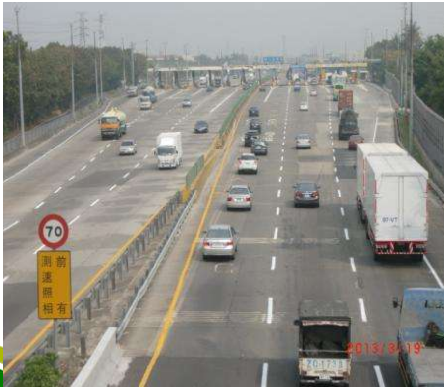
站區標線重繪標記重貼
