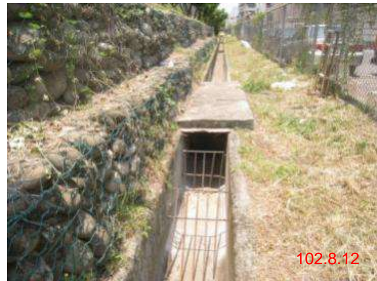
N上364k+700(建工路201巷100號 前)左側施作攔汙柵
