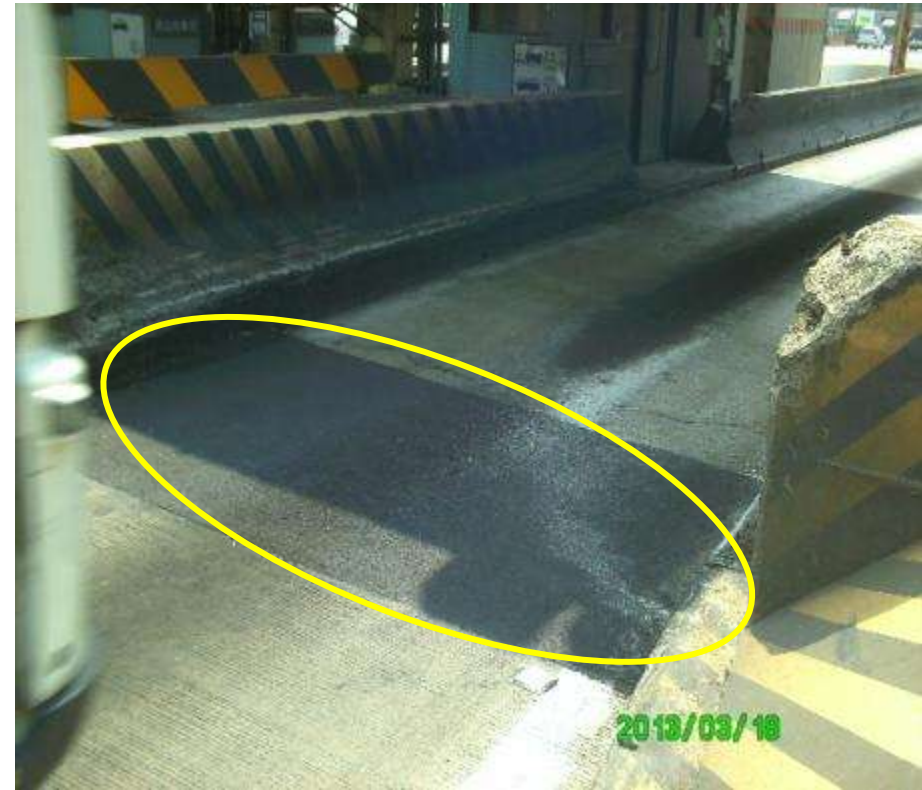
南下大型車道版塊段差填補
