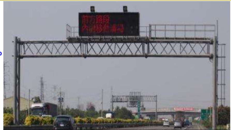
CMS預告前方內側移動性施工
