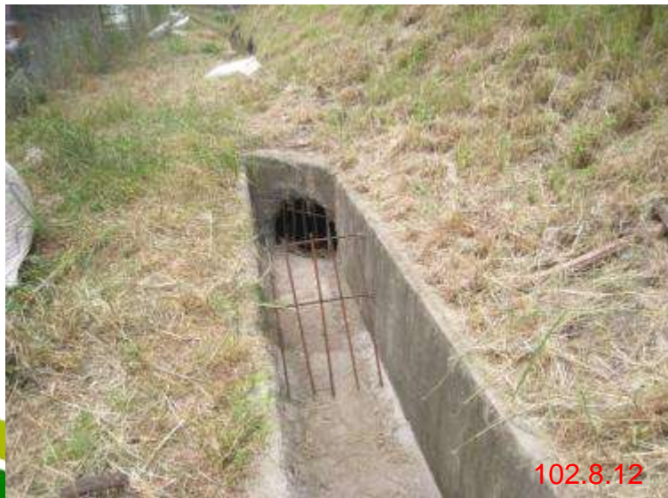
N上365k+334(皓東路246巷70弄 口)左側施作攔汙柵
