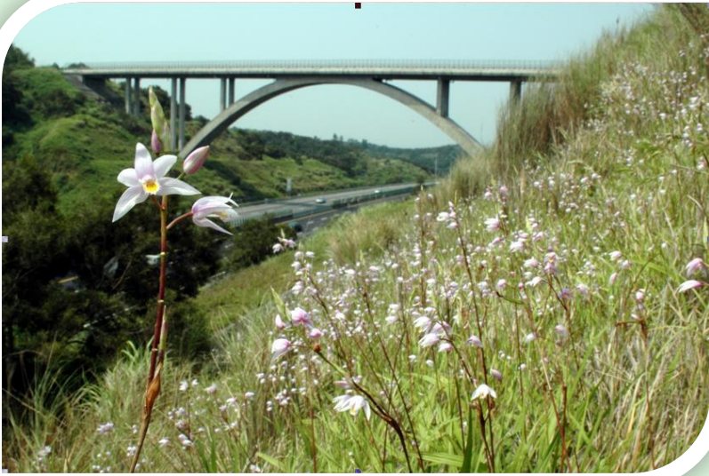
拍攝地點：國道3號通霄路段邊坡
