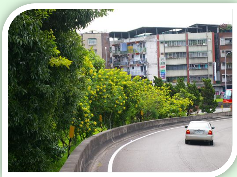
拍攝地點：國道1號三重交流道
