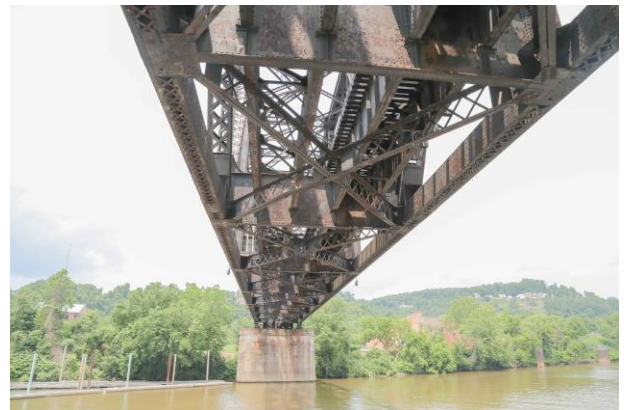
照片4-7 防蝕塗裝已產生剝落、銹蝕嚴重之鋼橋
