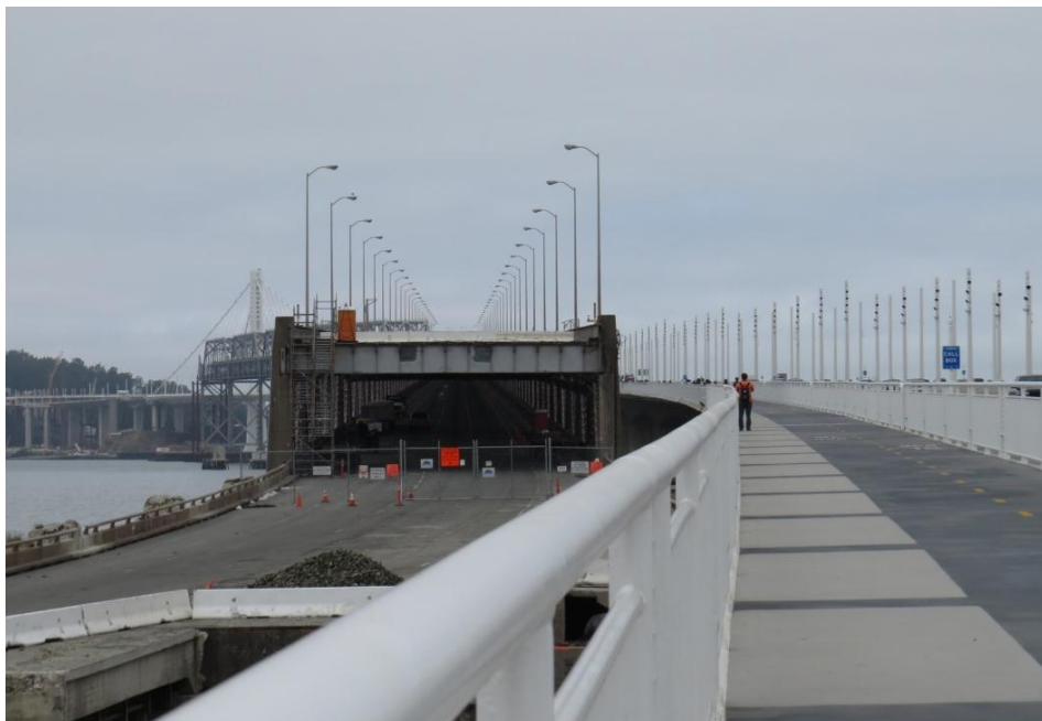
照片 3-4 左側為舊上下雙層海灣大橋傳統路燈，右側為新橋與新式 LED 路燈
