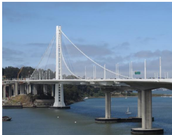
照片3-2 新海灣大橋，單柱式不對稱自錨定式懸索橋
