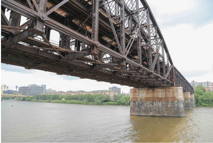
照片4-8 使用耐候鋼材之鋼橋
