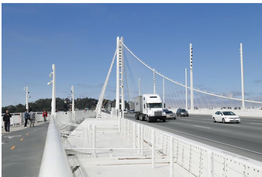
照片 4-1 海灣大橋南側的人行與腳踏車步道
