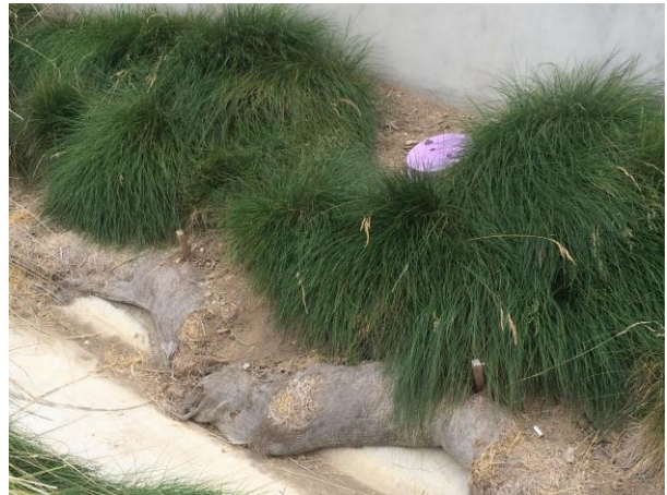
照片 4-6 雨水回收清潔口
