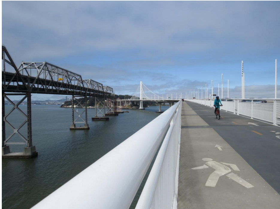
照片 3-3 左方為拆除中的舊橋，右方為新橋
