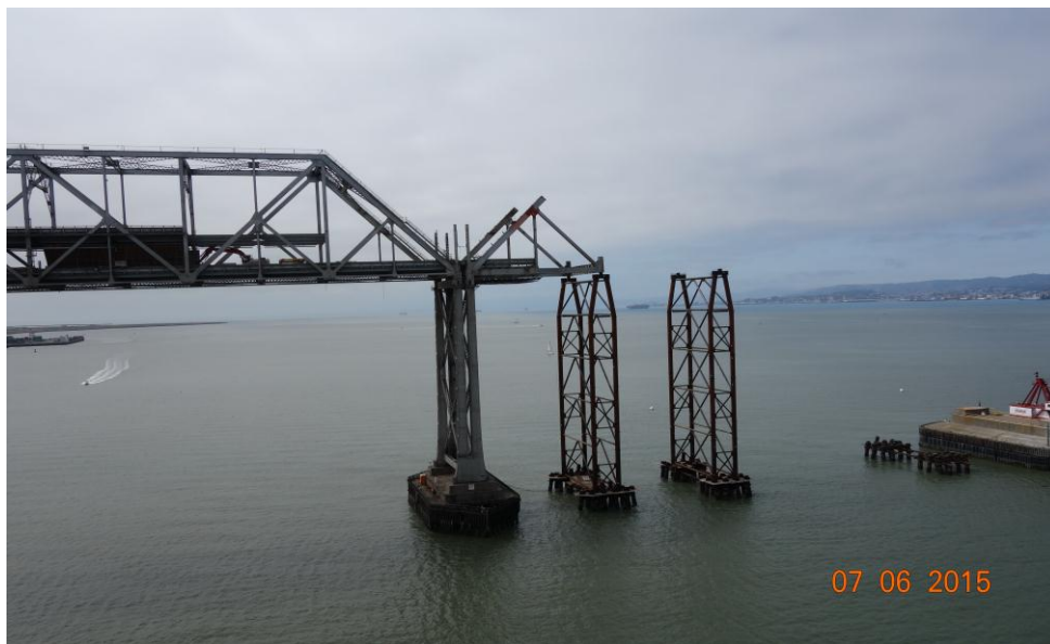
照片 3-7 構築臨時橋墩以支撐舊橋上部結構再進行拆除
