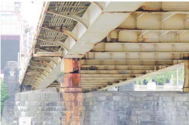
照片4-7 防蝕塗裝已產生剝落、銹蝕嚴重之鋼橋
