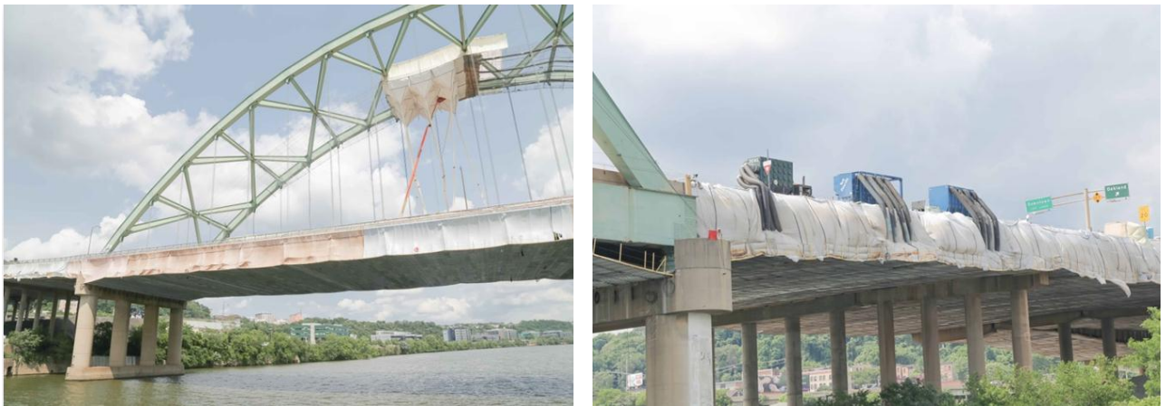
照片4-9 鋼橋維護塗裝施工
