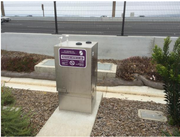
照片 4-5 雨水回收噴灌系統
