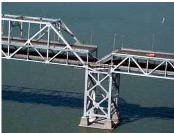
照片3-1 1989年舊金山大地震使舊海灣大橋東段上層橋面板垮
