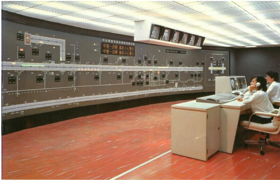
基隆-楊梅段交控系統完成後之泰山控制中心
