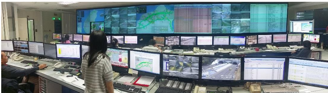
104 年 11 月配置修正後之泰山控制中心
