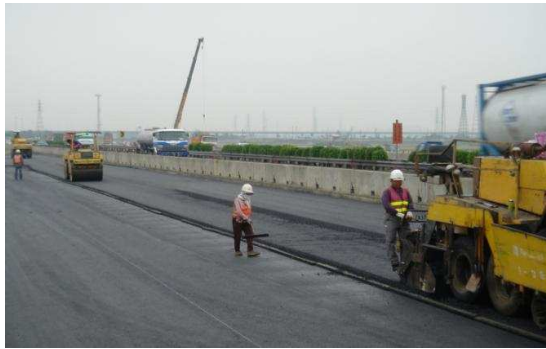
國道鋪面養護及排水孔道清理
