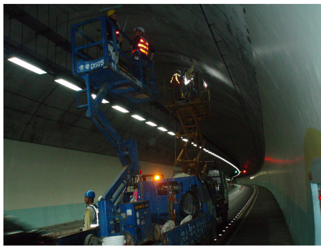
雪山隧道入口增設照明設備
