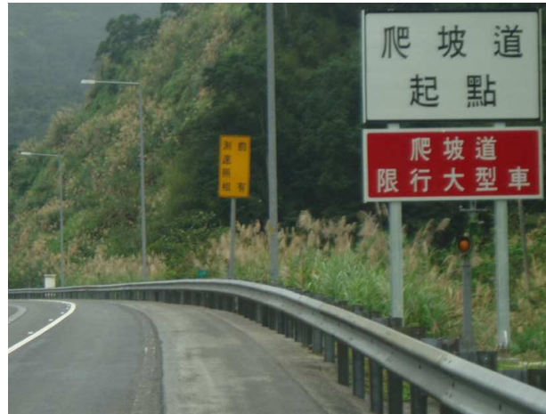
增設「爬坡道限行大型車」標誌
