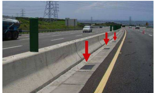
國道鋪面養護及排水孔道清理
