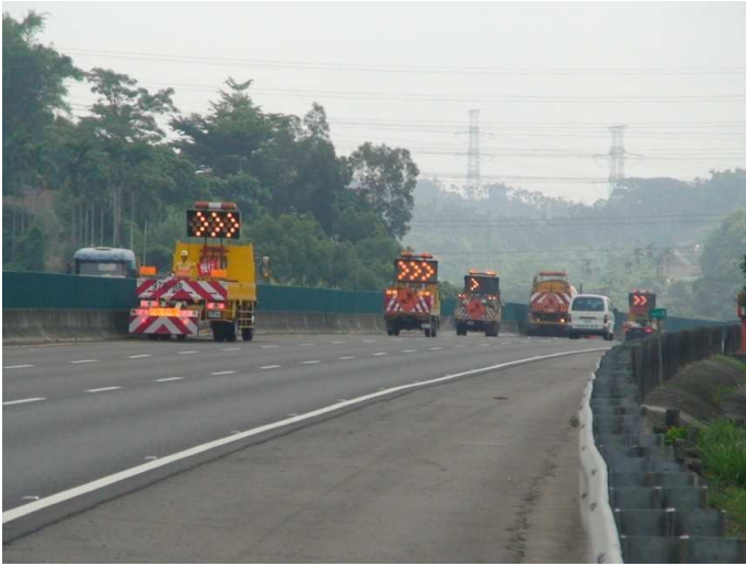
緩撞設施結合移動性施工警示車作業情形
