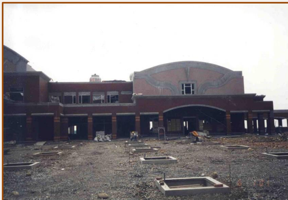
古坑服務區施工
