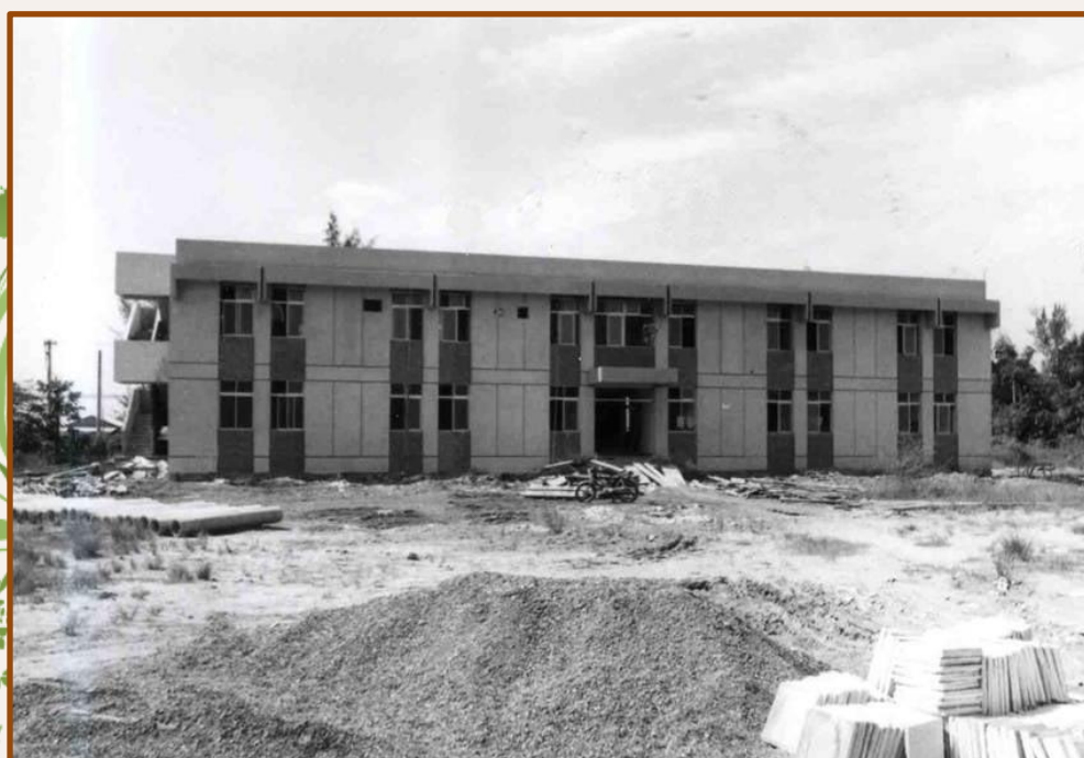
南區工程處舊大樓施工
