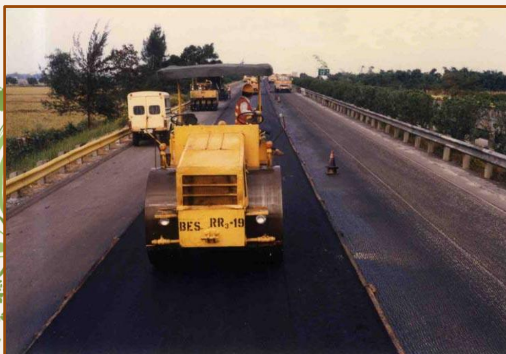
三輪壓路機滾壓
