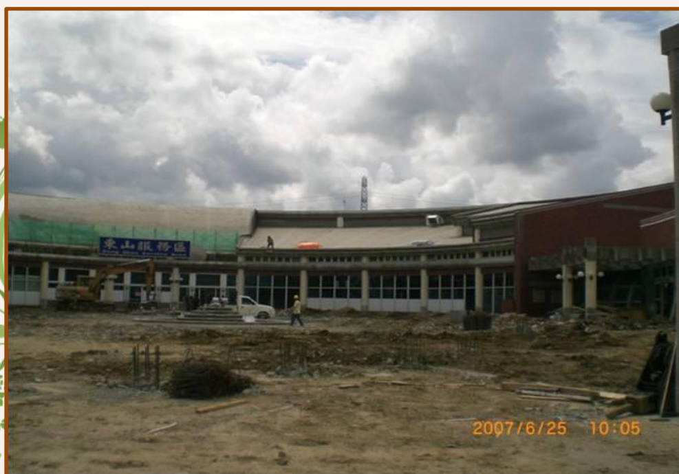
東山服務區施工
