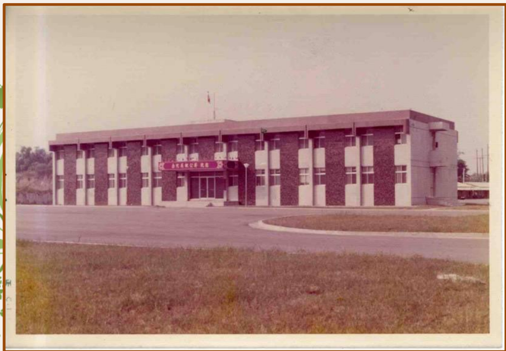
南區工程處完工後
