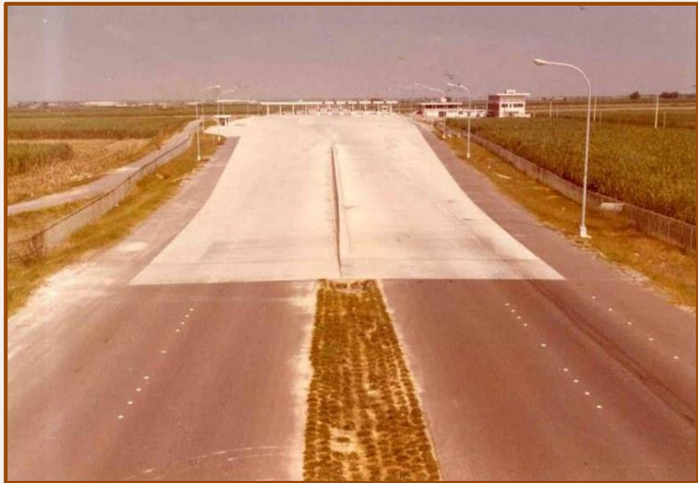
岡山收費站施工中
