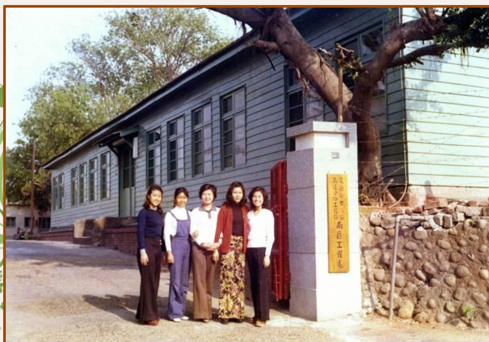
高速公路工程局南區工程處原始辦公室
