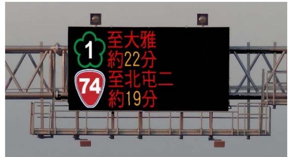
改善臺中都會區路網旅行時間，利用偵測辨識率較高之新型設備，使路網資訊準確率提高，配合本工程增設之路徑導引標誌，用路人能正確選擇有利之路徑，用最短時間到達目的地。
