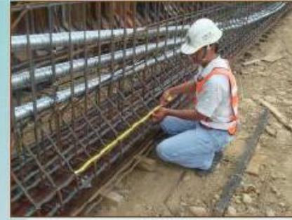
預力梁鋼筋查驗
