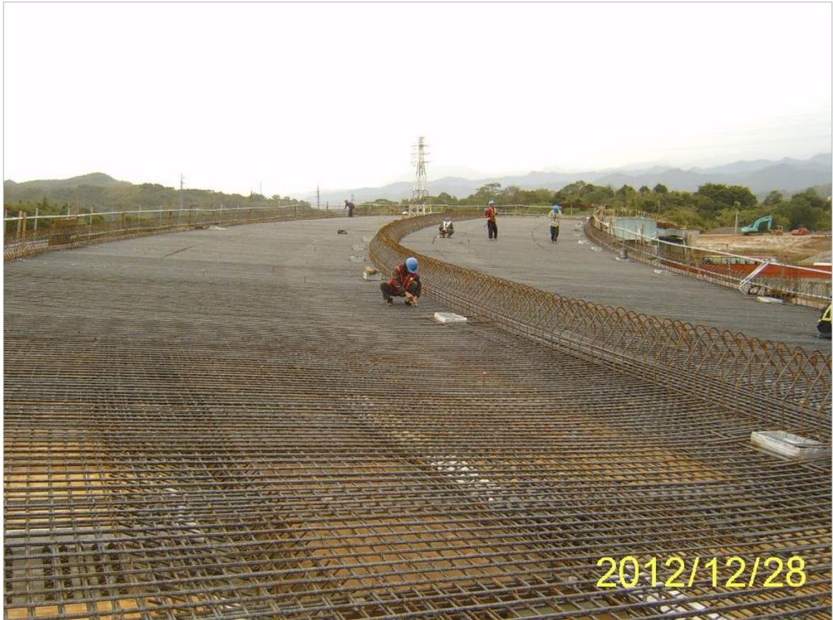
第 425 標工程 P2~P4 橋面板鋼筋綁紮
