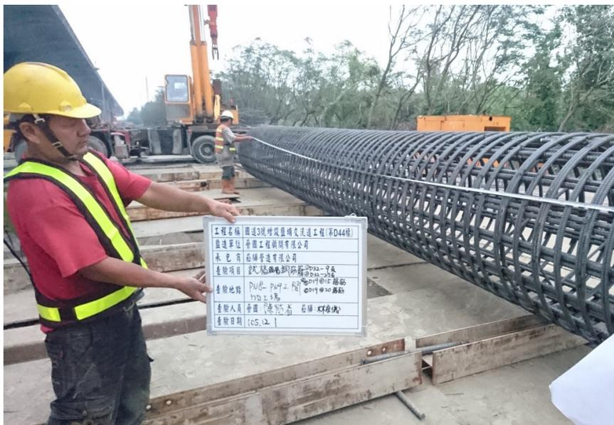
鹽埔交流道基樁鋼筋籠組立抽查
