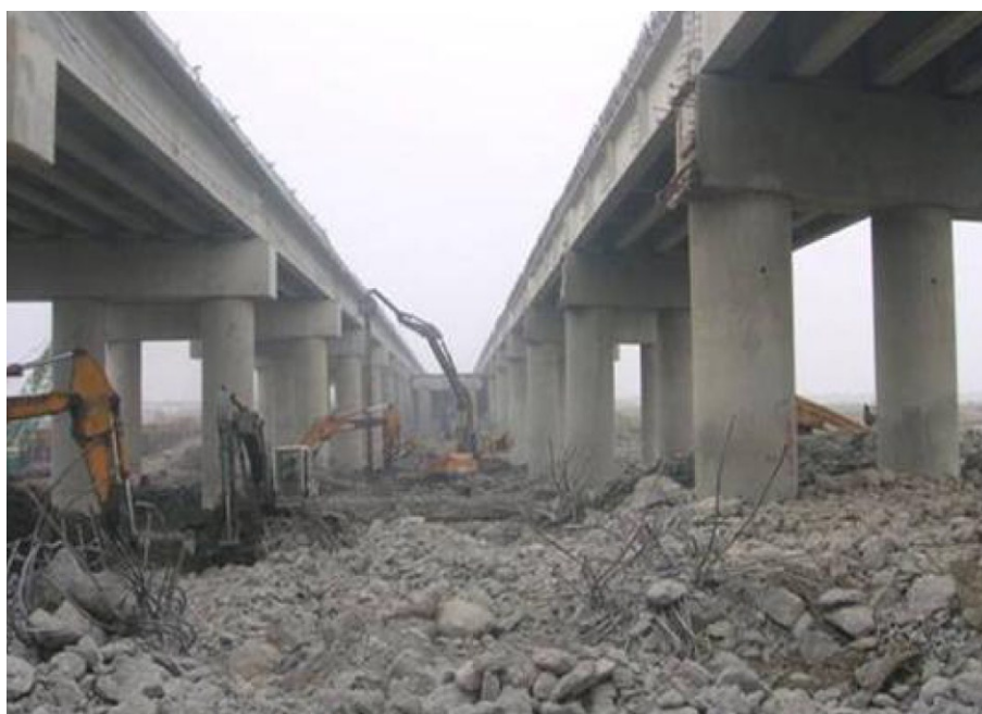
圖2.4 橋樑拆除改建施工步驟四
