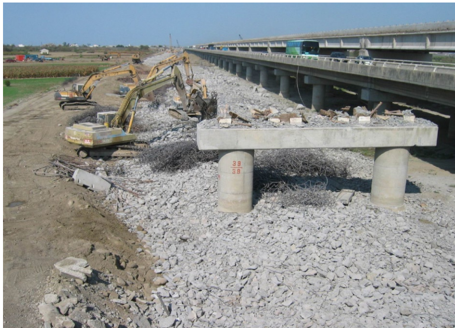
圖2.2 橋樑拆除改建施工步驟二
