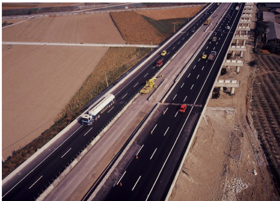
圖2.7 橋樑拆除改建施工步驟七
