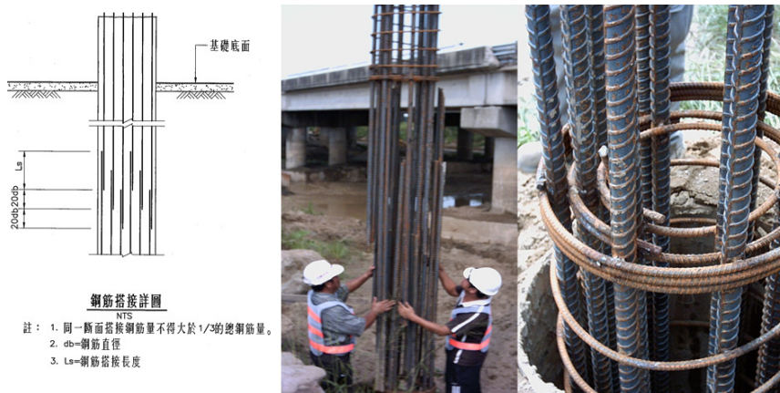
圖4.2-2 基樁鋼筋籠之搭接示意圖
