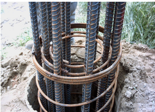
鋼筋籠吊放及澆置水中混凝土
