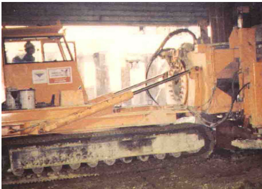
Tubex piles工法
