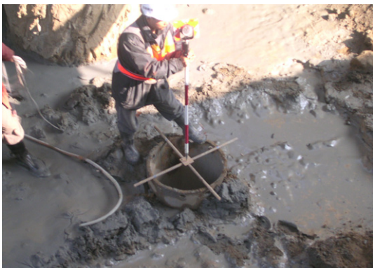
測量定位及鋼樁植入
