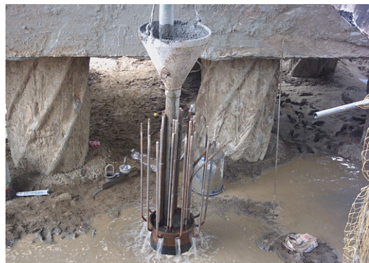
鋼筋籠吊放及澆置水中混凝土
