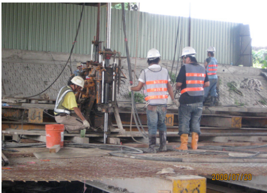
高壓噴射樁鑽孔及灌漿
