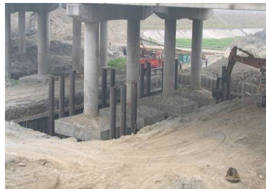
測量定位及鋼樁植入
