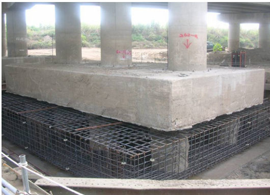
向下補強基礎鋼筋綁紮及灌漿(自充填混凝土)
