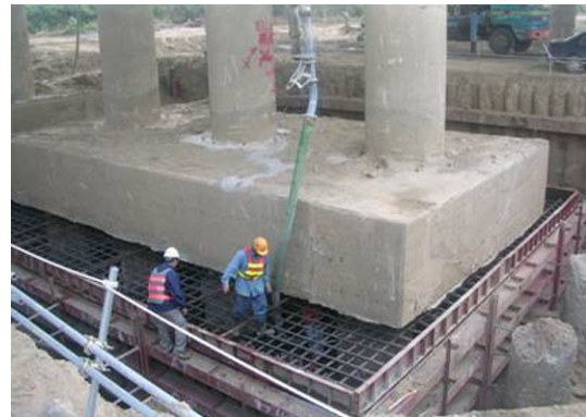
向下補強基礎鋼筋綁紮及灌漿(自充填混凝土)
