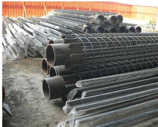
圖4.2-1 基樁鋼筋籠之鋼套環焊接示意圖
