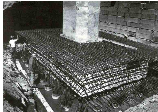
基礎鋼筋綁紮
