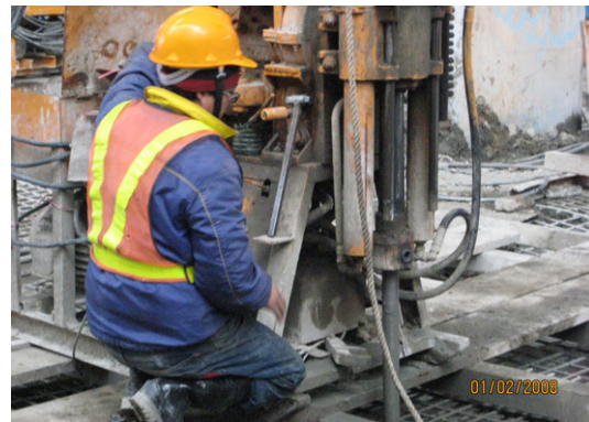
高壓噴射樁鑽孔及灌漿
