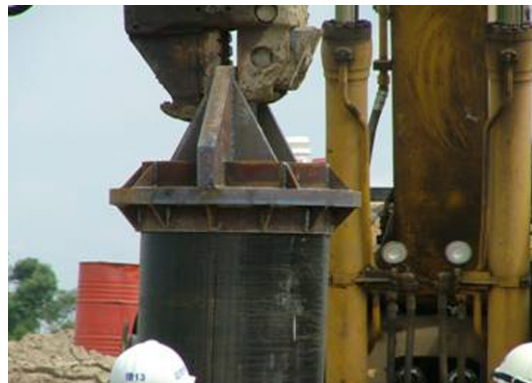
國內自行改裝工法—震動打擊式
