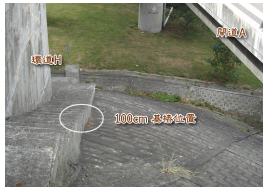
新竹系統交流道橋台現況
