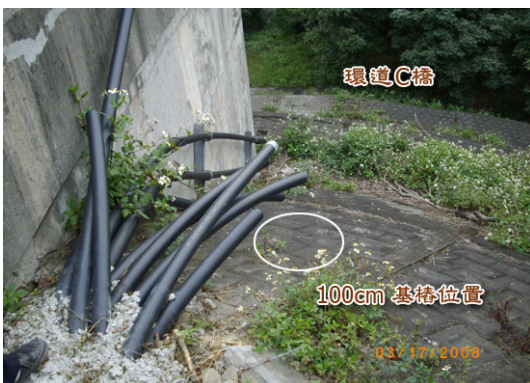
新竹系統交流道橋台現況
