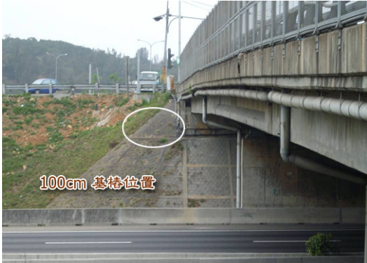
越橋橋台A1現況
