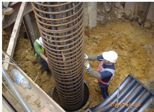
鋼筋籠吊放
