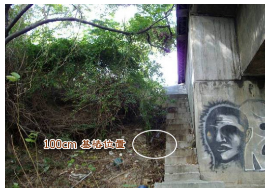
107K+986跨越橋橋台現況
