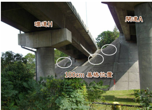
新竹系統交流道橋台現況
