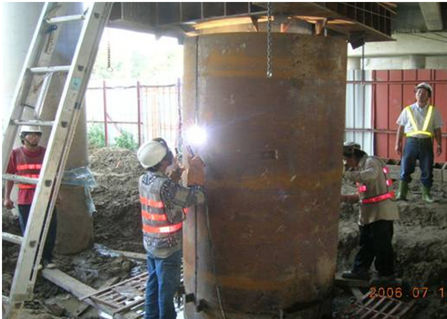
鋼管安裝焊接
