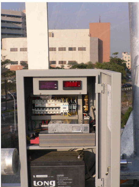
圖4-3系統控制箱設置
