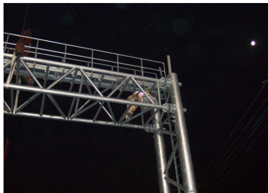
外側鋼構桁架接合螺栓鎖定其他收尾工作需於1小時30分鐘內完成
