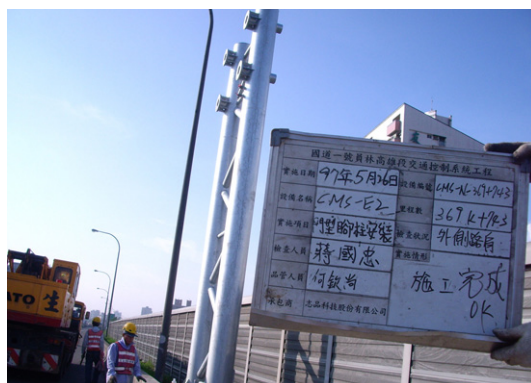
前置作業-吊裝前1天交維封閉外1車道，施工人員將鋼構桁架腳柱於施工位置(外側)
