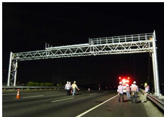
內、外側鋼構桁架接合螺栓鎖定及其他收尾工作全部施工完成，施工人員及吊車施工機具撤離全線開放通車
