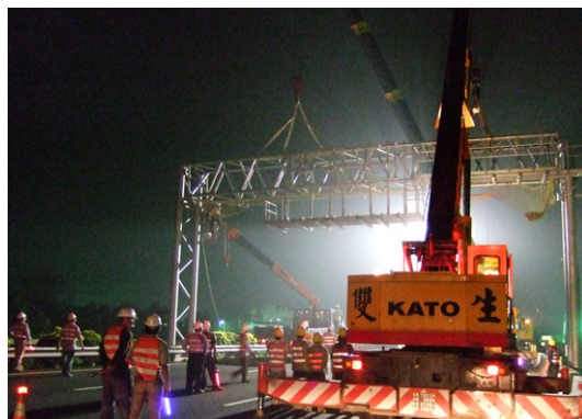
起吊鋼構桁架安裝於預先已立好桁架鋼柱上
