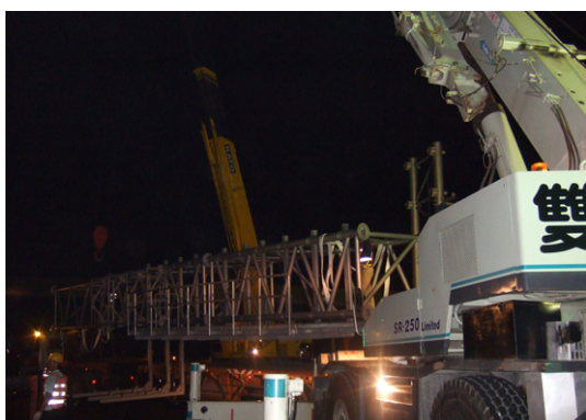
前置作業-吊裝前2小時交維封閉外1車道，施工人員機具鋼構桁架於施工位置就定位及吊掛作業準備工作
