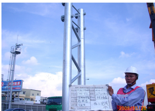
前置作業-吊裝前1天交維封閉內1車道，施工人員將鋼構桁架腳柱於施工位置(內側)
