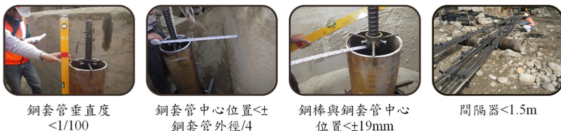
（圖8）高拉力鋼棒及鋼套管檢驗標準
