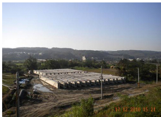
第434標工程RAMP A預力I型梁製作
