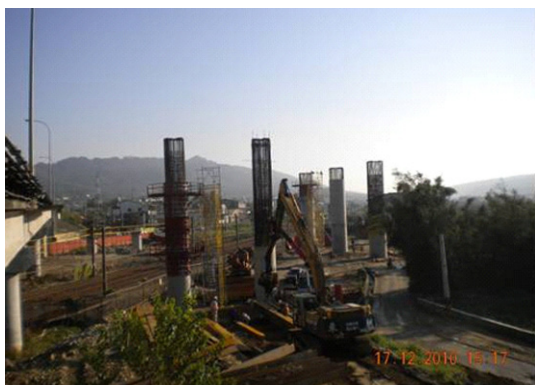
第434標工程聯絡道與匝道施作情形
