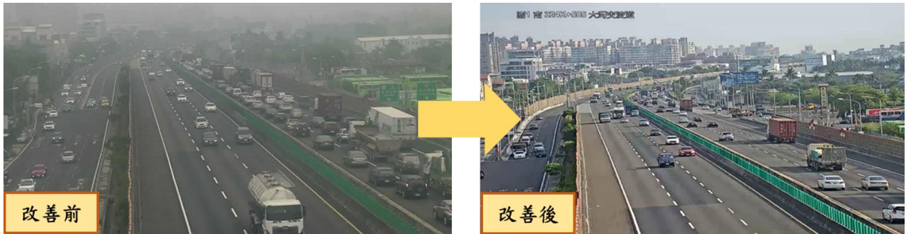
圖 7 國道 1 號北向大灣至永康開放路肩改善前後對照圖
