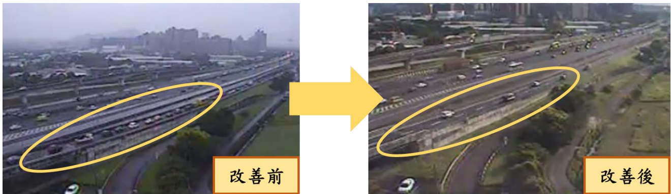
圖 17 國道 3 號樹林交流道南向出口改善前後對照圖
