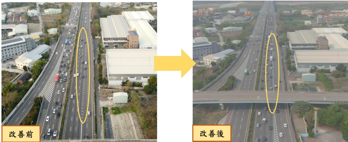
圖 2 國道 1 號台中系統交流道北向入口改善前後對照圖
