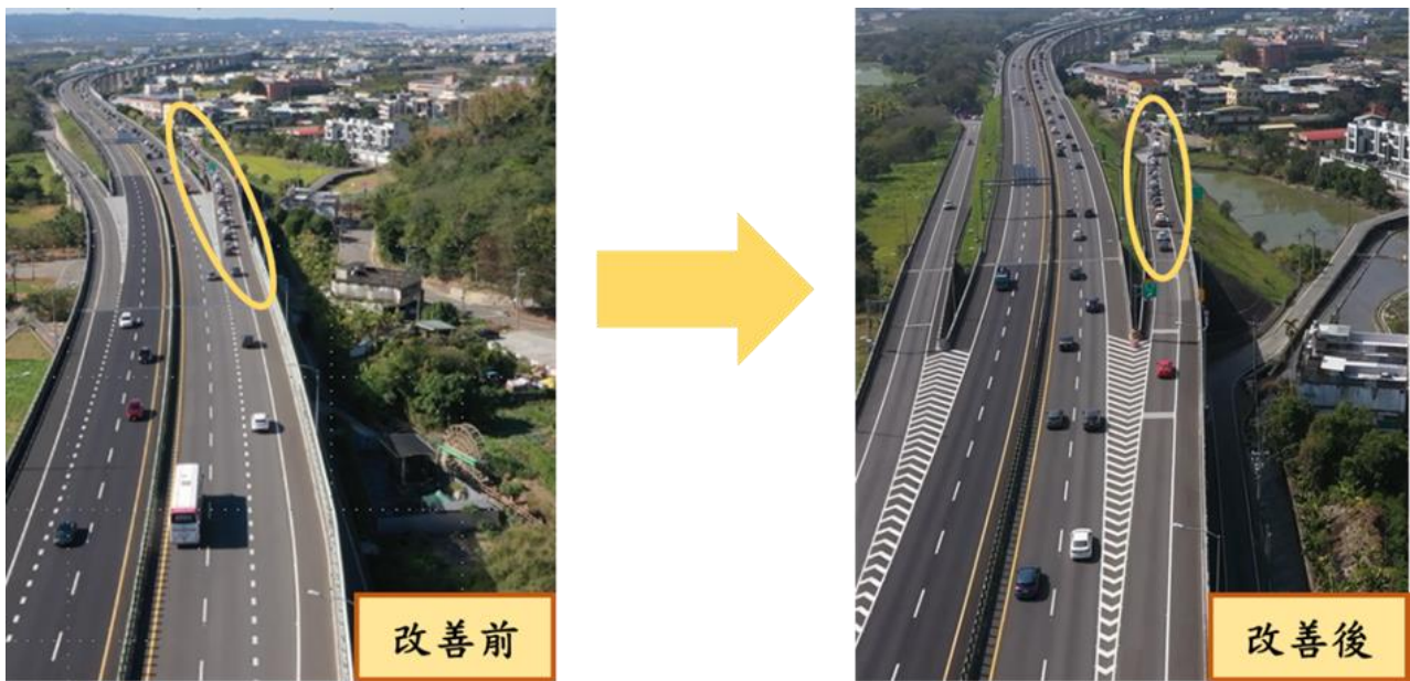
圖 10 國道 6 號舊正交流道西向出口改善前後對照圖
