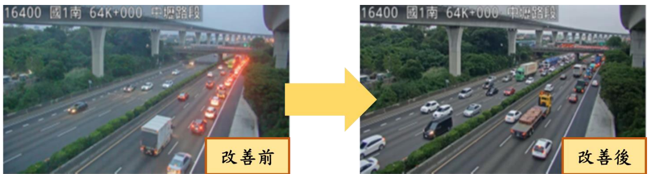
圖 10 國道 1 號平鎮系統交流道南向出口開放路肩改善前後對照圖
