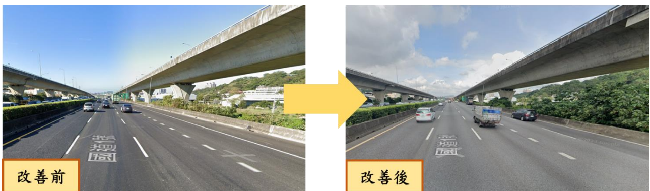
圖 4 國道 1 號南向林口至桃園改善前後對照圖
