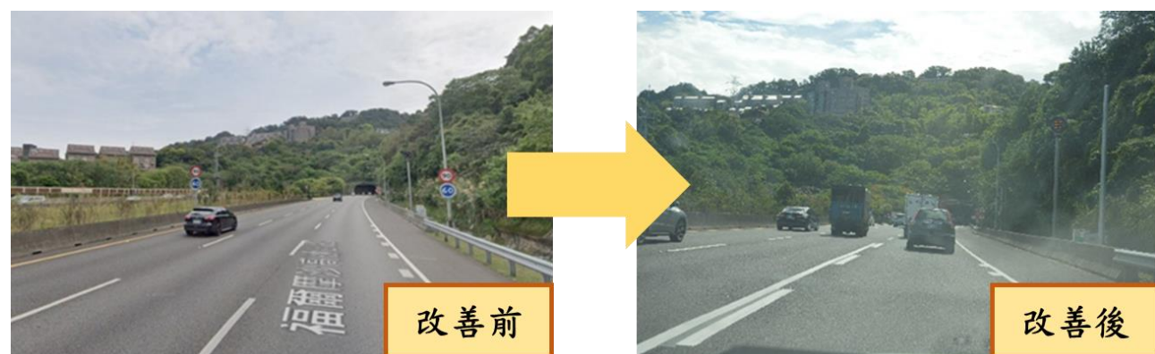
圖 13 國道3號中和交流道北向入口加速車道終點標線調整改善前後對照圖
