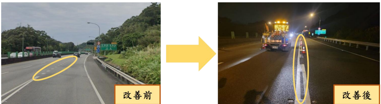
圖 19 國道 3 號甲線木柵交流道西向入口標線改善前後對照圖
