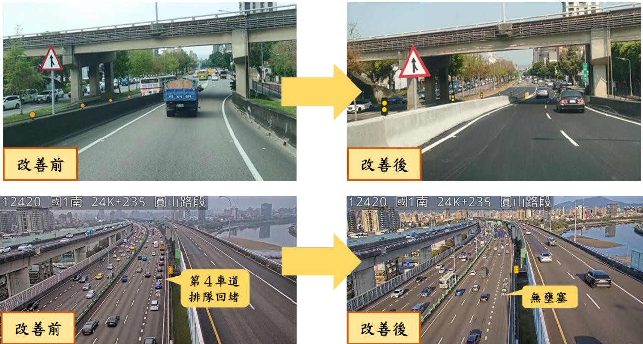
圖 6 國道 1 號台北交流道南向出口改善前後對照圖
