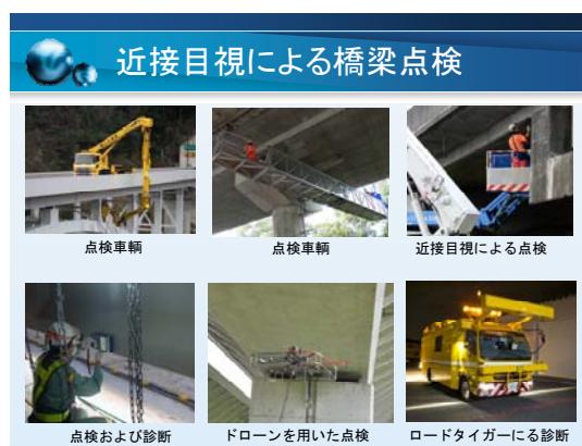
図-4 近接目視による橋梁点検
