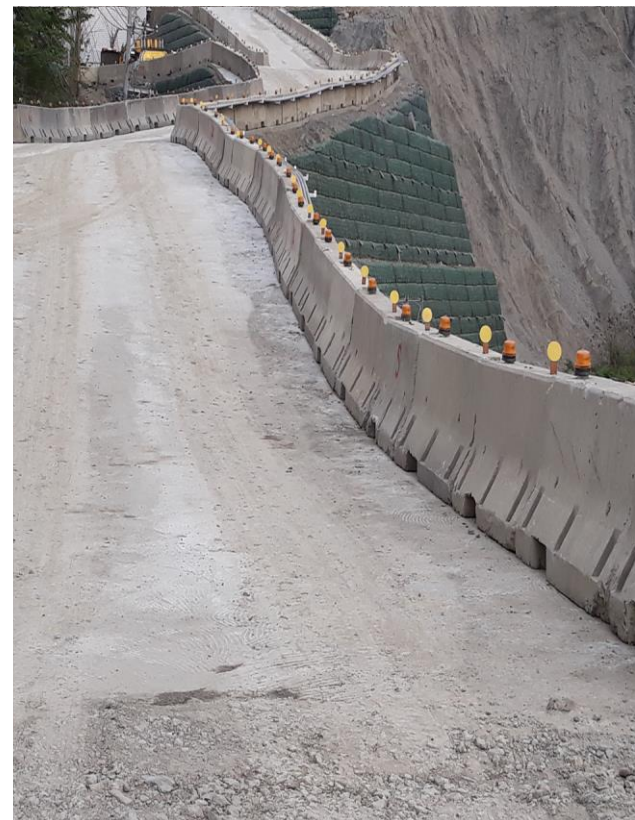
設置混凝土路面及RC護欄防墜
