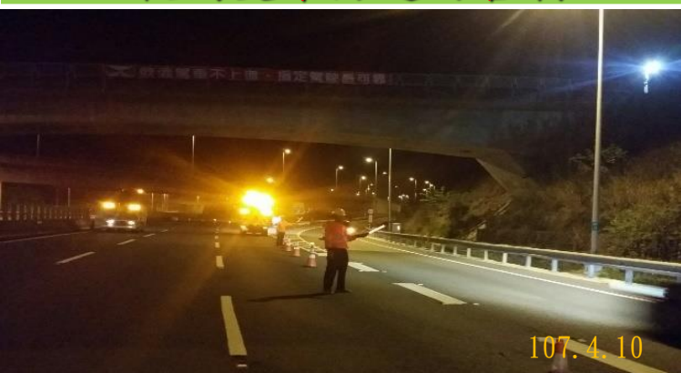
主線交維設施佈設
