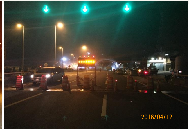
隧道拆除區前交維布設警戒
