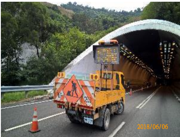
施工交維布設情況
