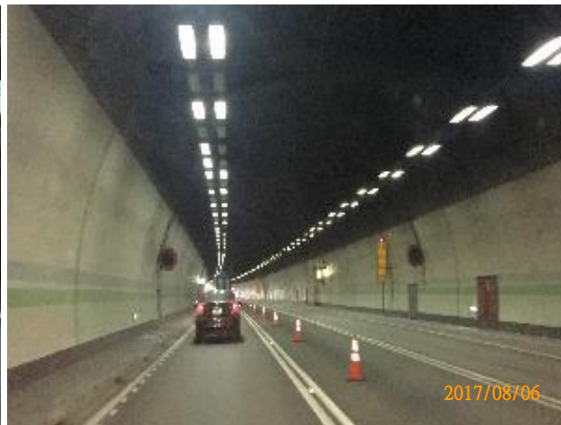
中寮隧道施工區交維情況
