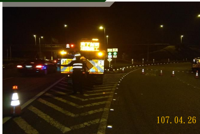
夜間交維設置旗手及LED車引導
