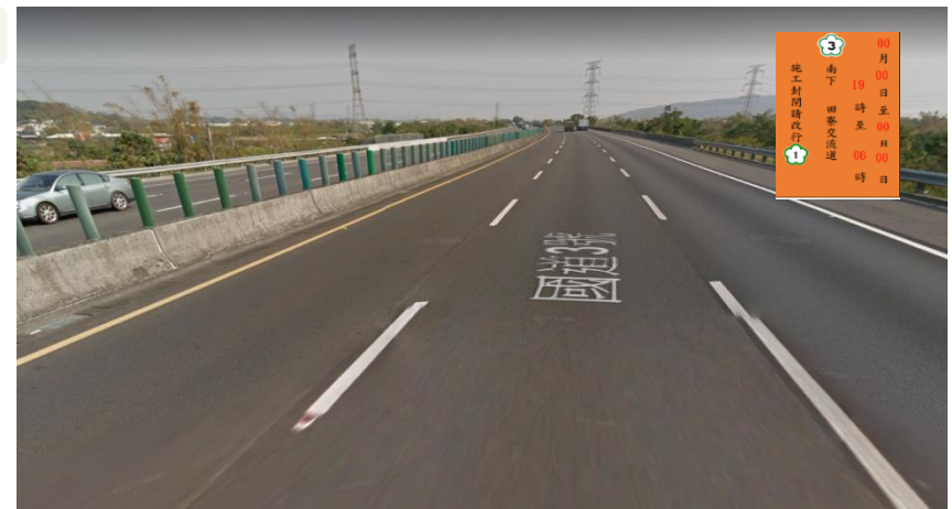
南下367k+880(國3田寮交流道夜間封閉起點)設置預告牌面
