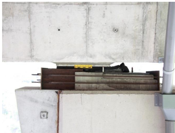
盤式支承錯移、增設鋼托架
