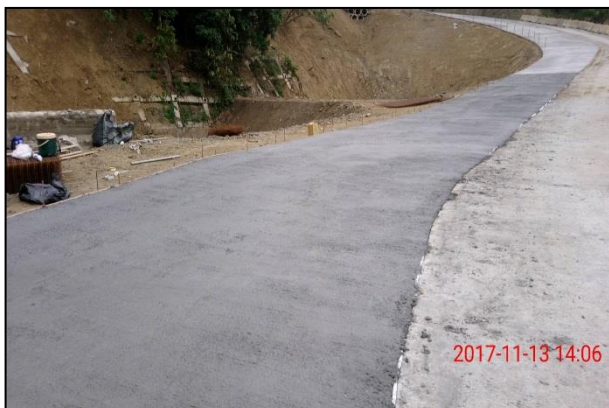
便道鋪築混凝土
