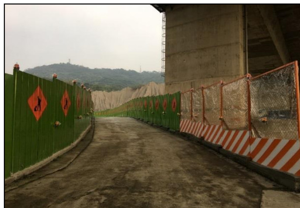
施工圍籬設置防溢座
