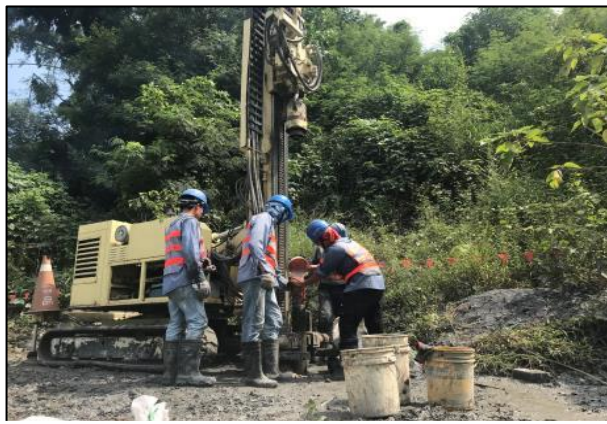
設置地下水井監測
