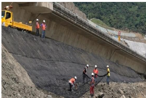
裸露地表覆蓋防塵網
