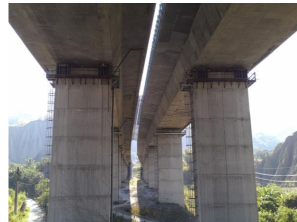
增設檢測爬梯及平台
