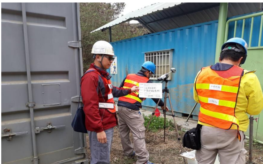
營建噪音振動監測
