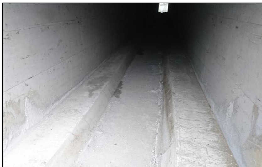
排水箱涵設置生物步道
