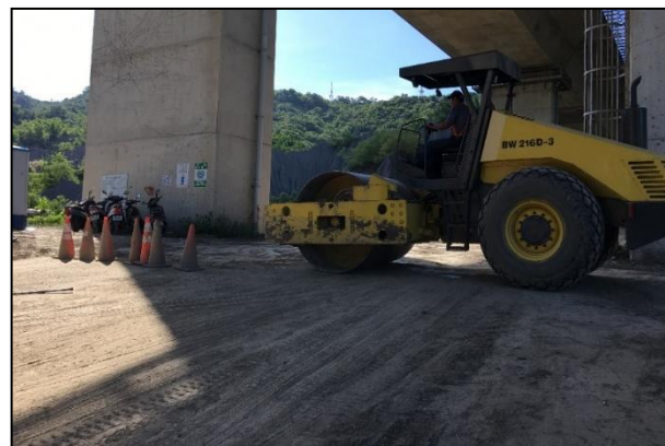
即挖即填，壓實防止揚塵
