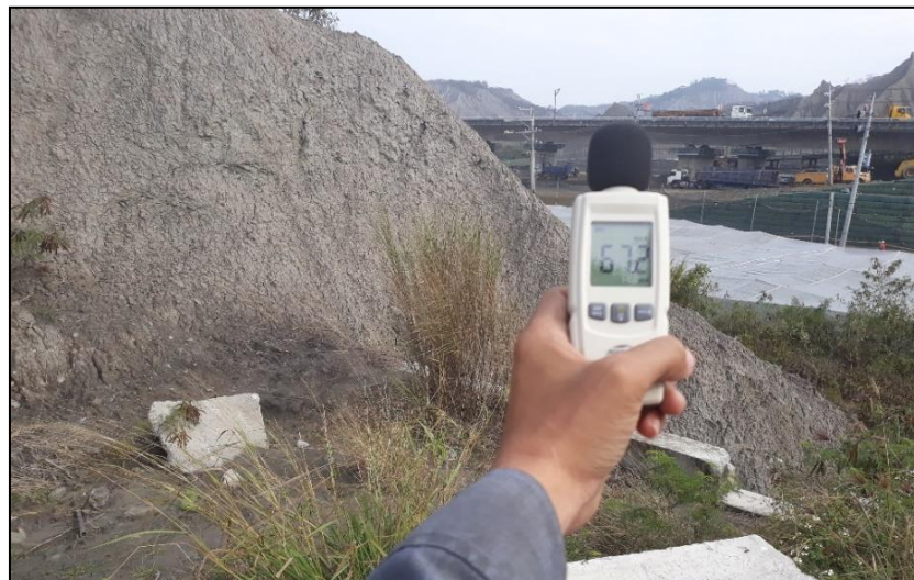
施工期間自主音量監測
