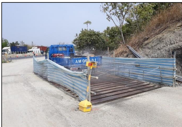
設置洗車台及沉澱池
