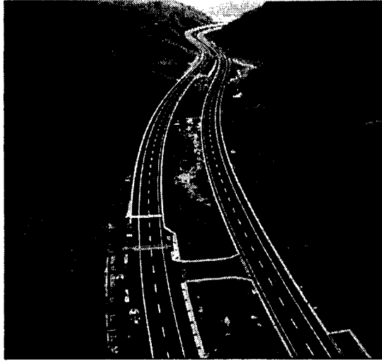
圖 4 北宜高速公路南港頭城段坪林一、二號高架橋
