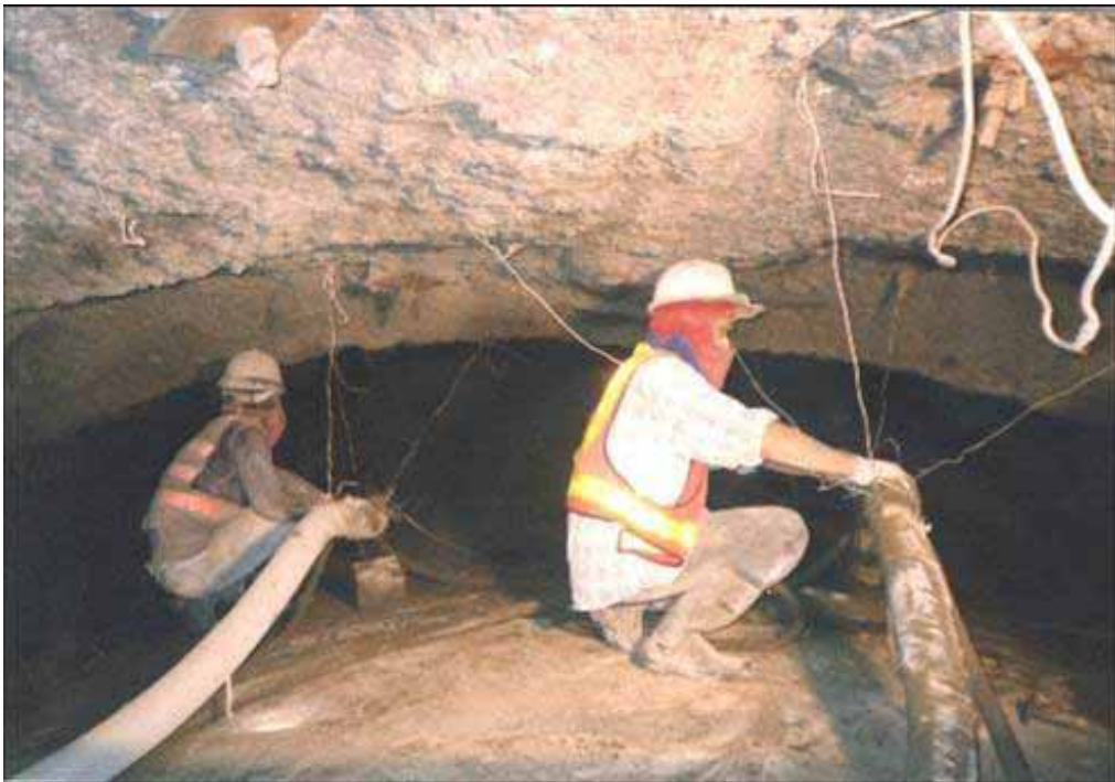
照片九、TBM 背填噴凝土作業
