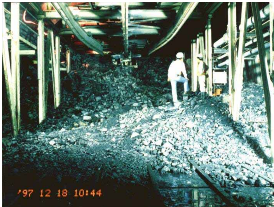
照片三、大量抽坍矧料湧入 TBM
