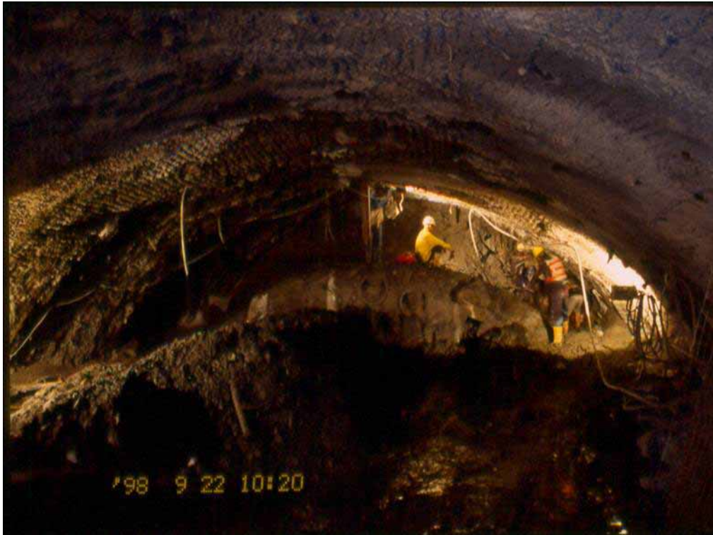
照片五、自機頭前方進行 TBM 清理作業
