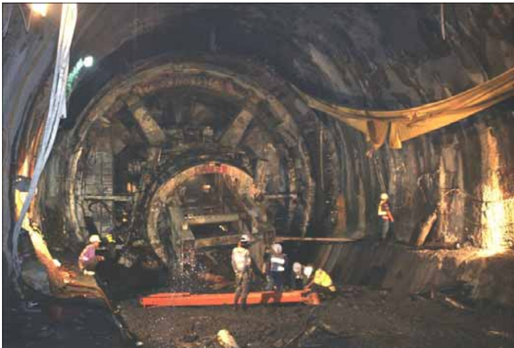
照片六、西行線 TBM 拆除作業
