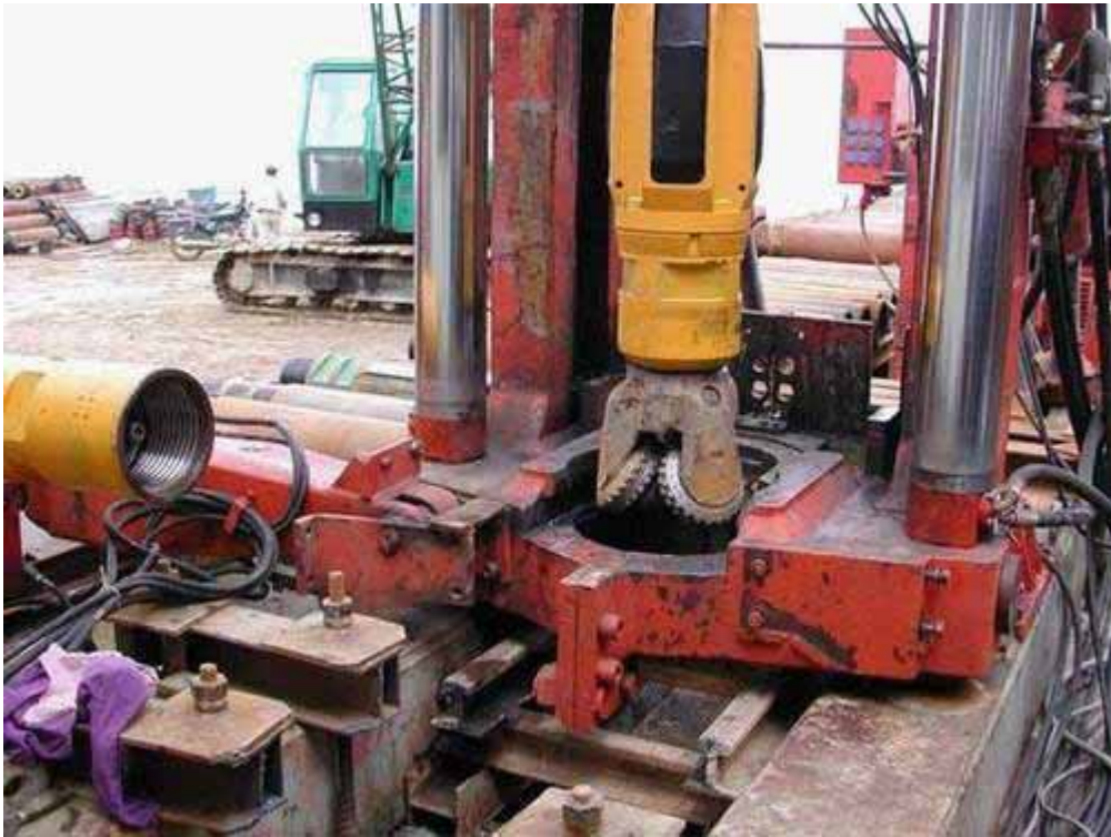
照片十、昇井工法鑽機導孔導向鑽孔系統
