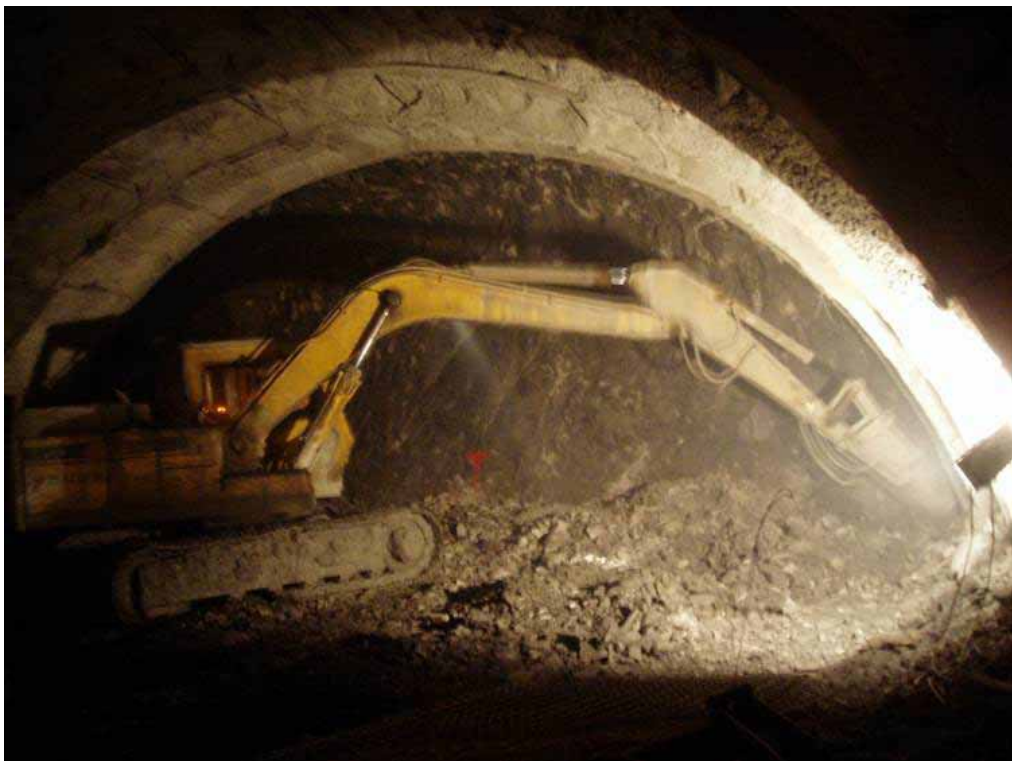
照片八、自 14 號人行聯絡道增闢東行線頂導坑開挖作業
