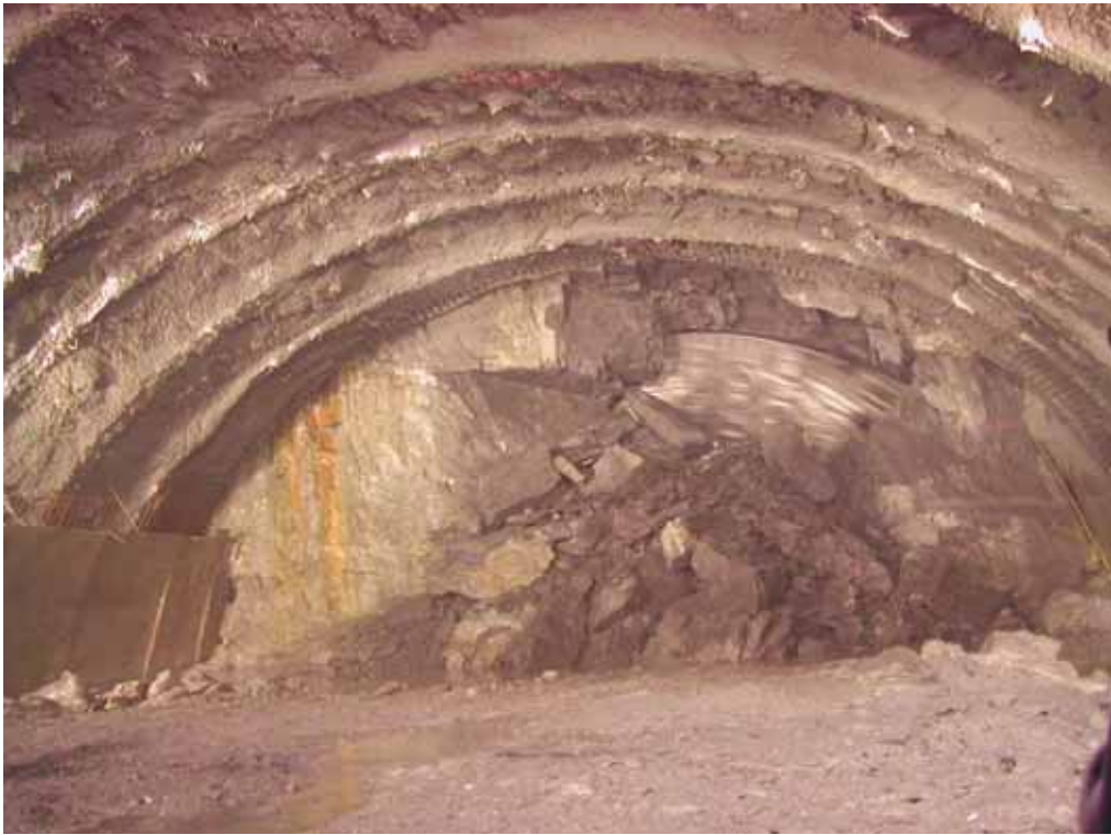
照片七、東行線 TBM 混凝土撐座
