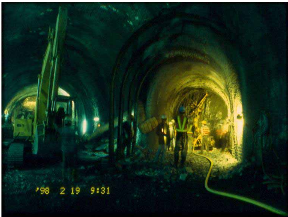
照片四、繞行隧道施工
