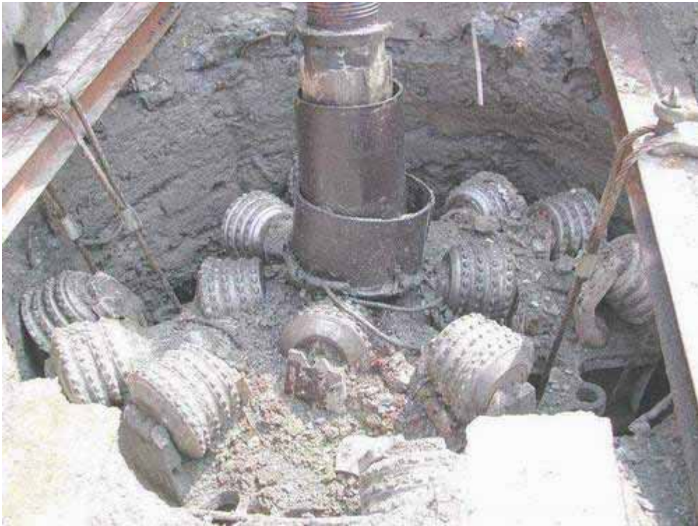
照片十四、昇井工法向上擴孔達頂
