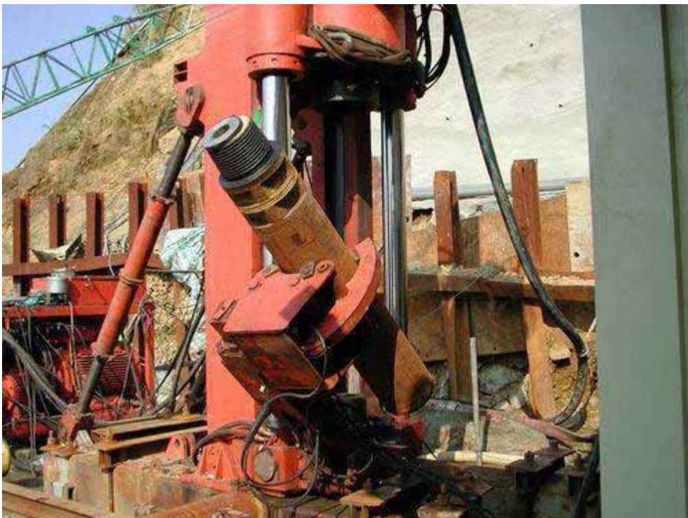
照片十一、昇井工法鑽機自動接管裝置
