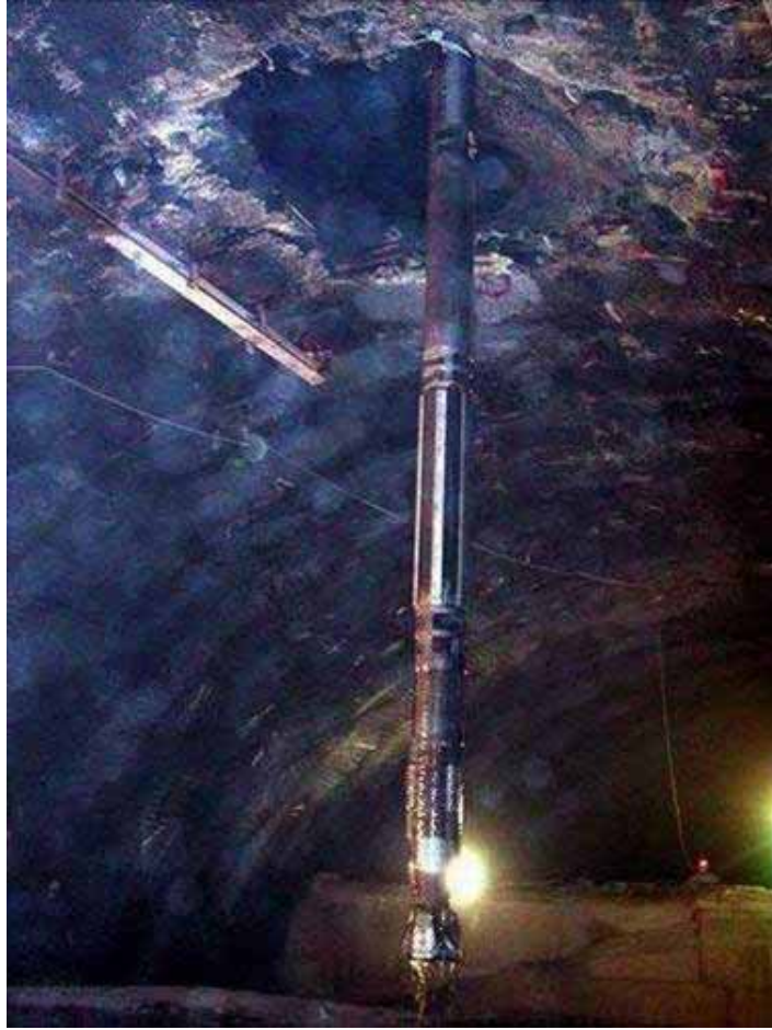
照片十二、昇井工法導孔貫通
