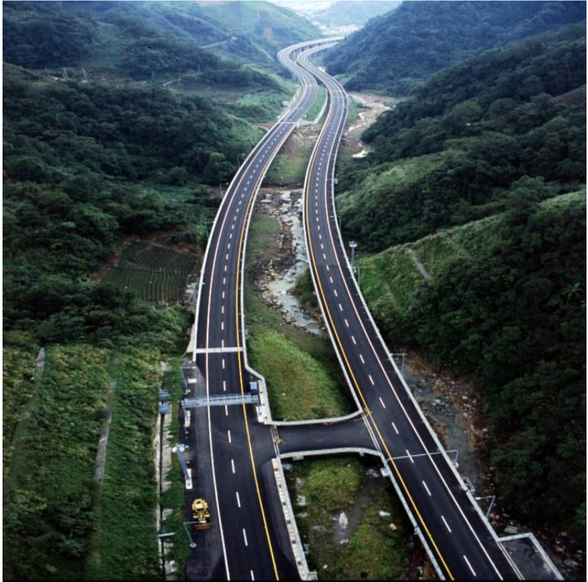
圖 4 北宜高速公路南港頭城段坪林一、二號高架橋
