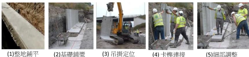
(1)整地鋪平 (2)基礎鋪漿 (3)吊掛定位 (4)卡樁連接 (5)細部調整
