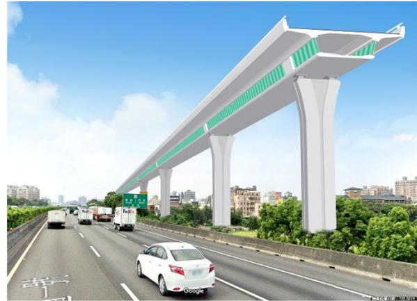
圖 4.3-2 複合波浪形鋼腹板梁橋
