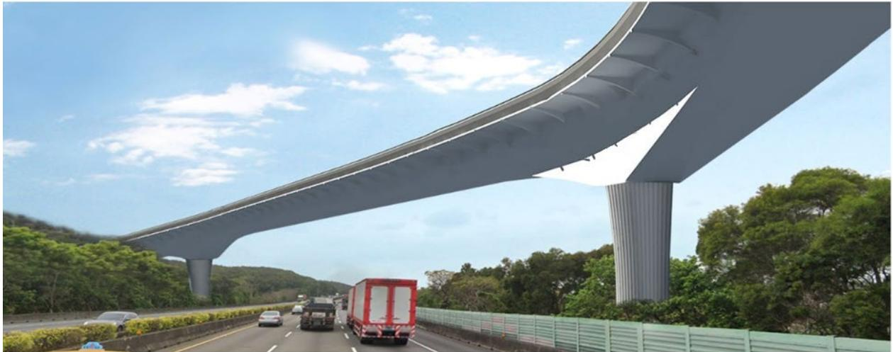
圖 4.3-6 南下線中山高跨越橋(變斷面預力箱型梁橋)及橋墩造型美化模擬圖
