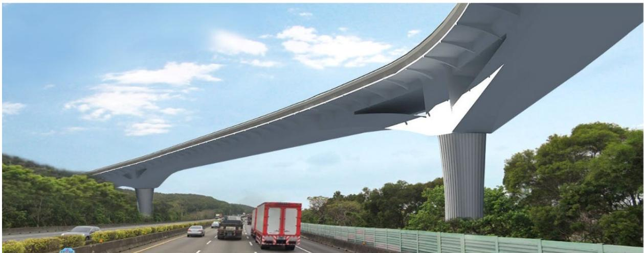
圖 4.3-8 南下線中山高跨越橋(鏤空式預力箱型梁橋)及橋墩造型美化模擬圖
