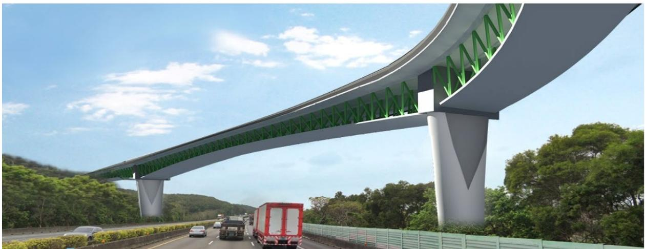
圖 4.3-7 南下線中山高跨越橋(複合桁架鋼管梁橋)及橋墩造型美化模擬圖
