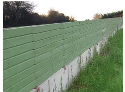
圖 4.5-22 預鑄 L 型擋土牆施工後圖
