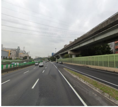
南下配置：主線三車道、匯入CD-R一車道，高架CD-R二車道
