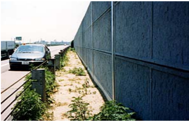
Kazo Expressway, Tokyo, 大塊混凝土牆
