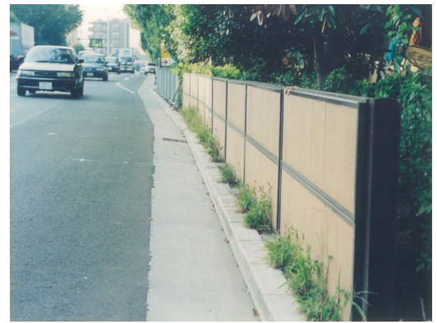
日本環7 低層隔音壁
