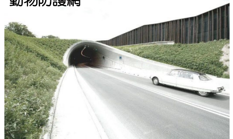
融合地貌隧道出入口
