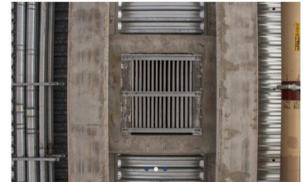
高架橋下蝙蝠棲所
