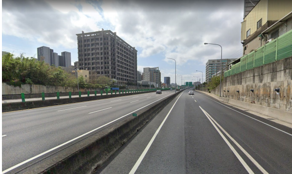
南下配置：主線三車道、集散道路二車道
