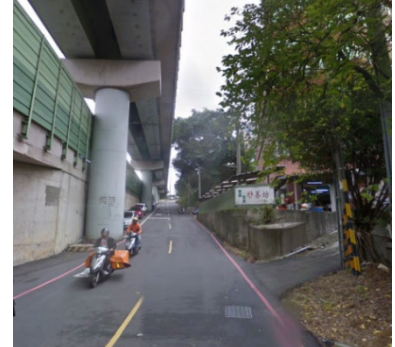
南下線外側地方道路雙向二車道(大學路51巷)
