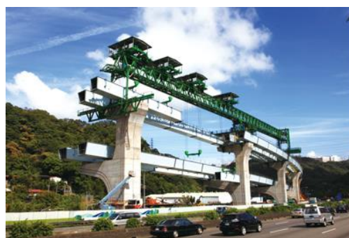
圖 15 鋼構自走式吊裝工法
