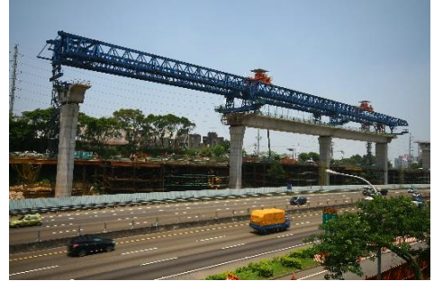
圖 7 預鑄節塊吊裝工法
