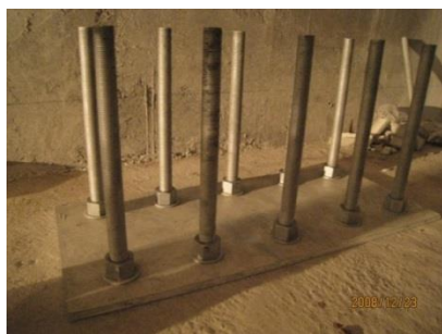
圖 14、鋼棒安裝施工示意圖
