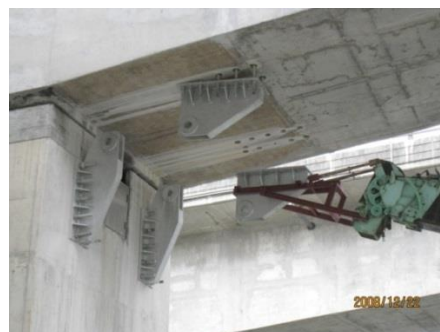
圖 15、上下托架安裝施工示意圖
