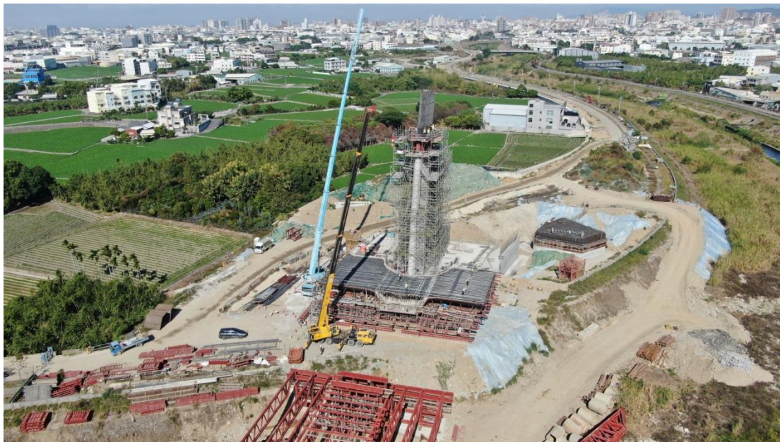
↑ 照片 2：豐原連絡道景觀橋主塔施工情形
