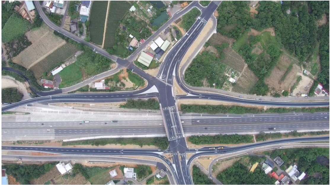
圖 1-國道 3 號增設高原交流道空拍
