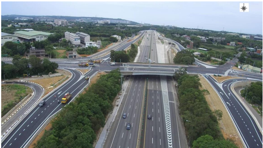
圖 2-國道 3 號增設高原交流道空拍
