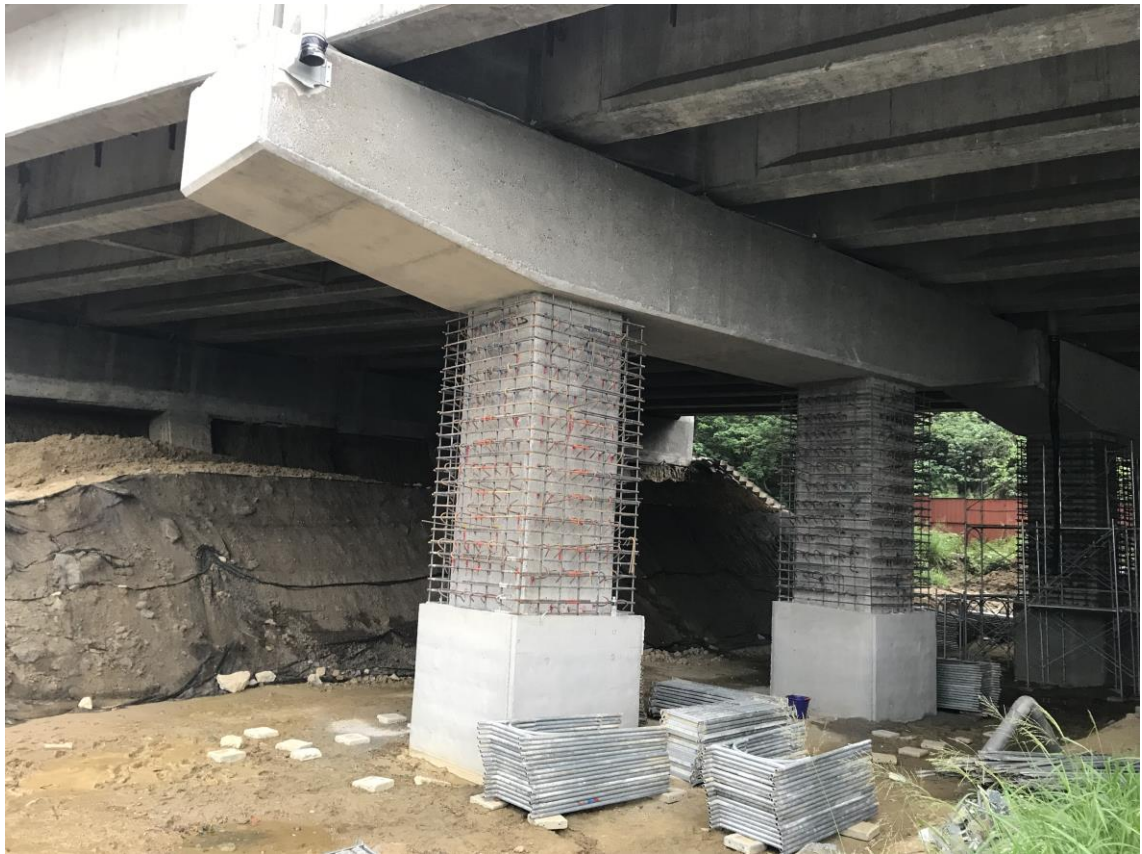
圖 3 橋梁耐震補強 - 墩柱混凝土包覆補強
