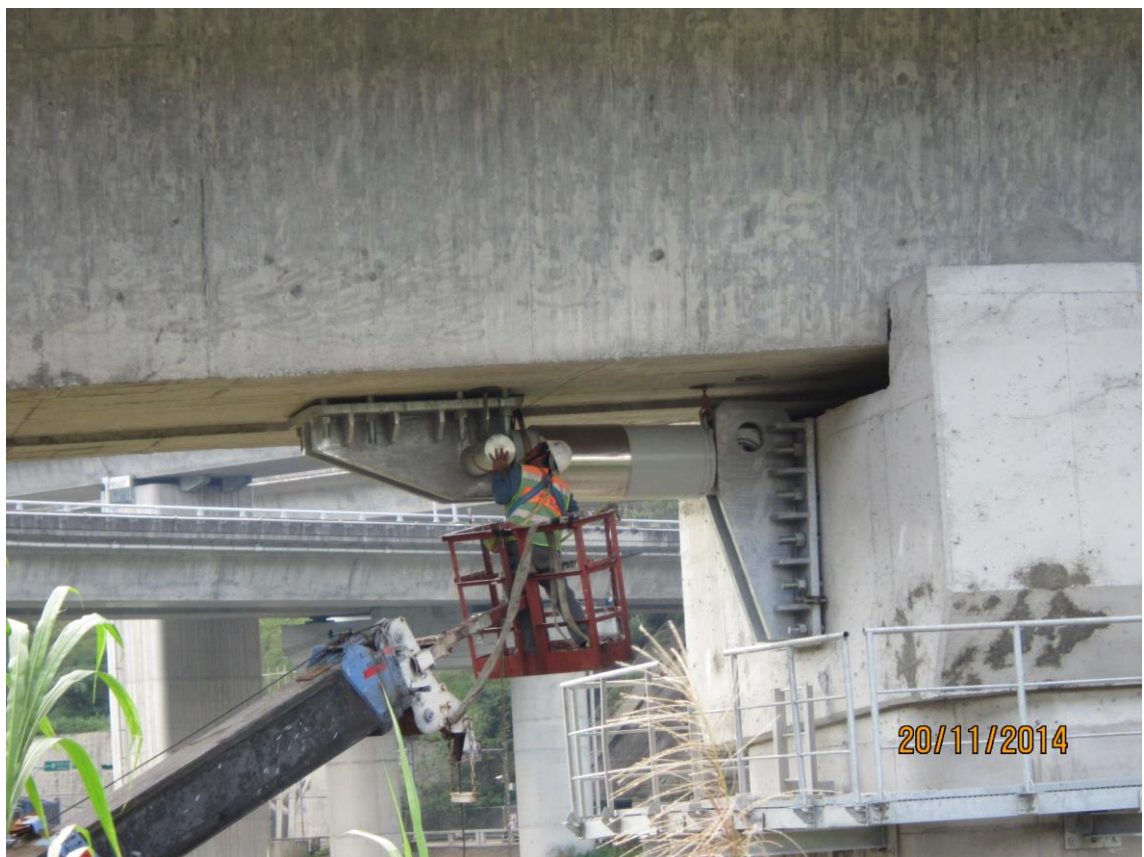
圖 4 橋梁耐震補強 - 增設阻尼器
