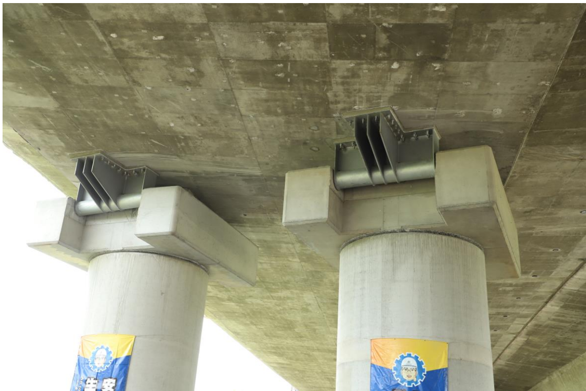
圖 2 橋梁耐震補強－增設鋼板止震裝置
