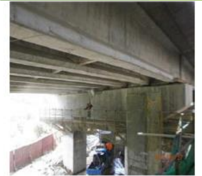
(b)混凝土表面水刀處理照片
