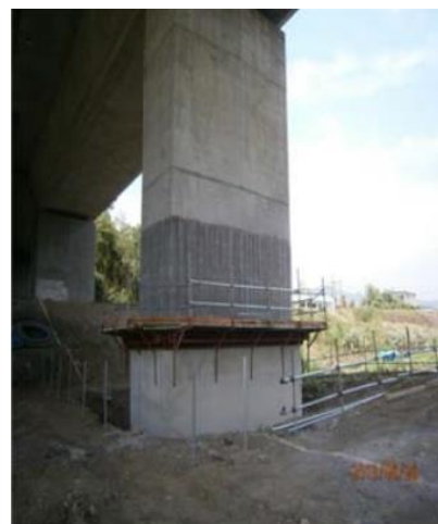
(a)施工架搭設
