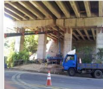
(a)施工架搭設照片
