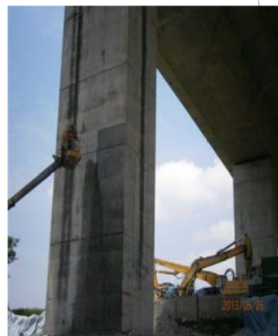
(b)橋墩混凝土表面水刀處理
