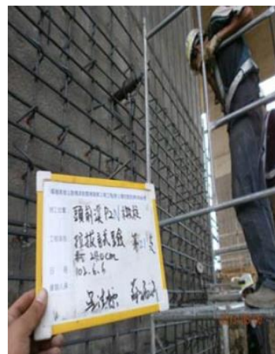
(d)鋼筋植筋施作
