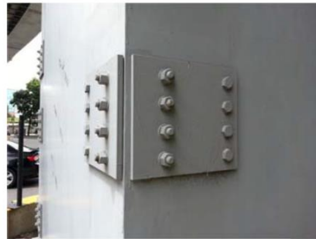
(d)加勁板施工完成 25
