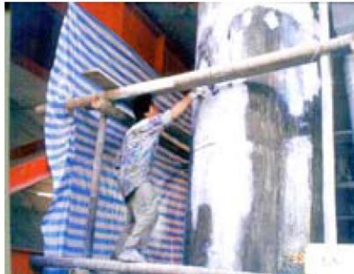
(d) Primer and putty applying (e) FRP attachment
