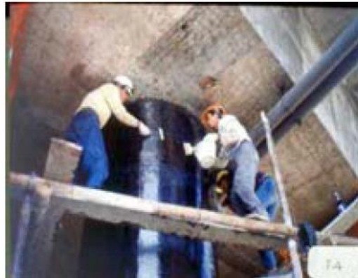
(d) Primer and putty applying (e) FRP attachment
