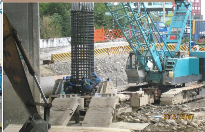
3. 鋼筋籠續接(鋼套環)
