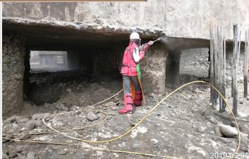
7. 基礎混凝土澆置
