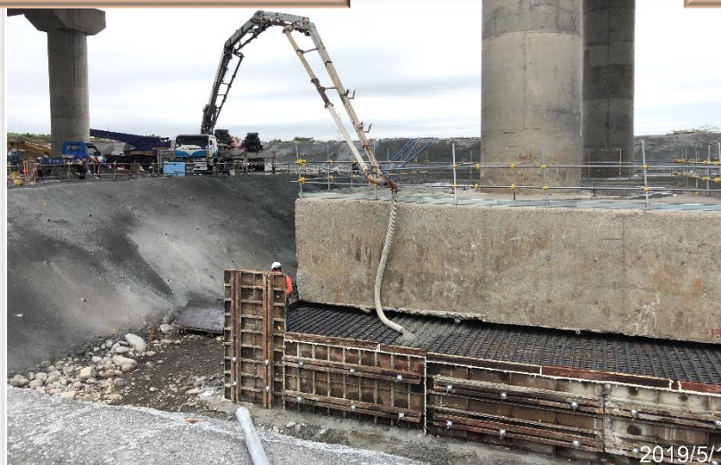
7. 基礎混凝土澆置
