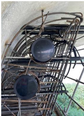
錨座與外喇叭管、鋼製喇叭管安裝
