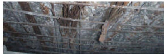
写真-2 PCケーブル破断
