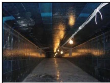
写真 5-1 炭素繊維シートによる耐震補強の例
