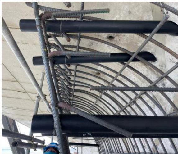
錨座與外喇叭管、鋼製喇叭管安裝
