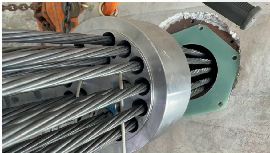
安裝感測器/定位器/絕緣板/錨頭
