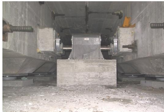
圖17: SS 147高架橋安裝的MELOTP阻尼系統。
