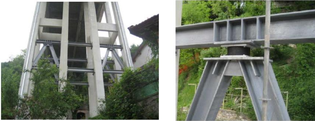
圖22: MELOP阻尼系統安裝(左)，安裝震動傳輸連接橋面板(右)
