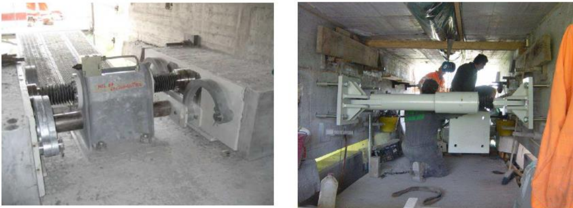
圖22: MELOP阻尼系統安裝(左)，安裝震動傳輸連接橋面板(右)
