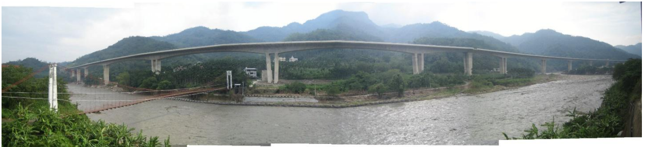
圖 6.4.3-2 變斷面預力混凝土箱形梁橋（斗山二號高架橋）
