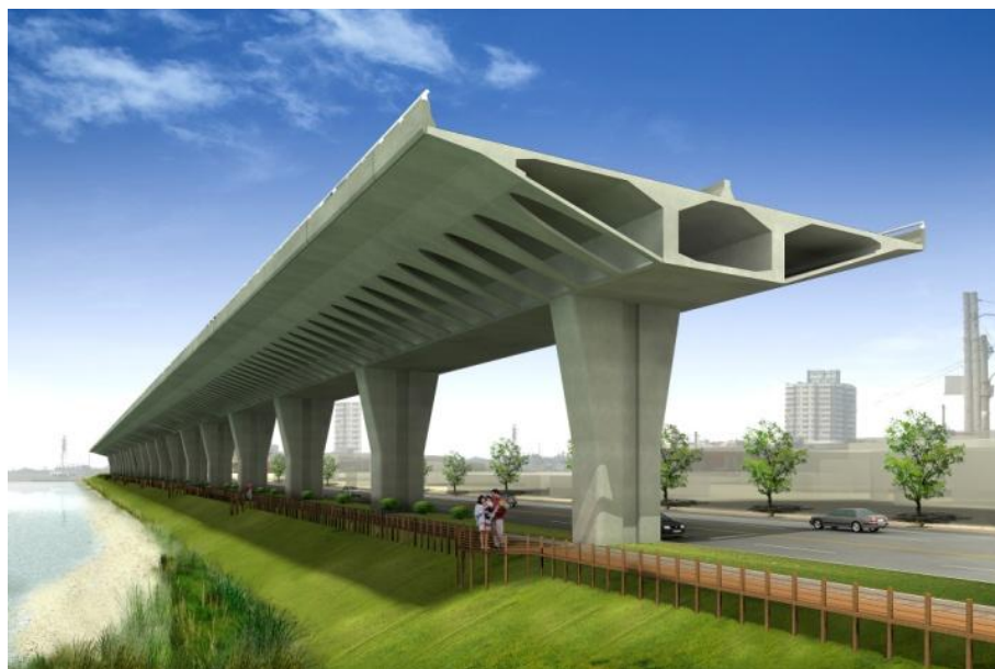
圖 6.4.3-1 預鑄斜撐板預力混凝土箱形梁橋示意圖
