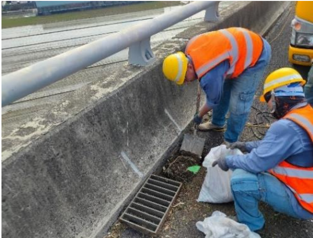
圖 1 橋梁洩水孔清理作業
